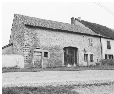
Ferme cadastrée 1951 B3 214, située rue de la Mûre. Phot. Yves Sancey IVR43_19793900145X
