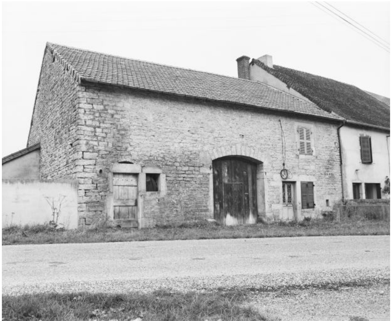
Ferme cadastrée 1951 B3 214, située rue de la Mûre.
