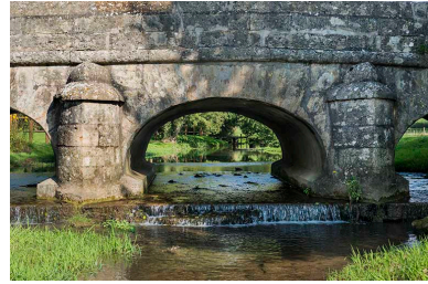
La voûte centrale. Phot. Jérôme Mongreville IVR43_20167001652NUC4A
