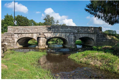
Vue générale. Phot. Jérôme Mongreville IVR43_20167001651NUC4A
