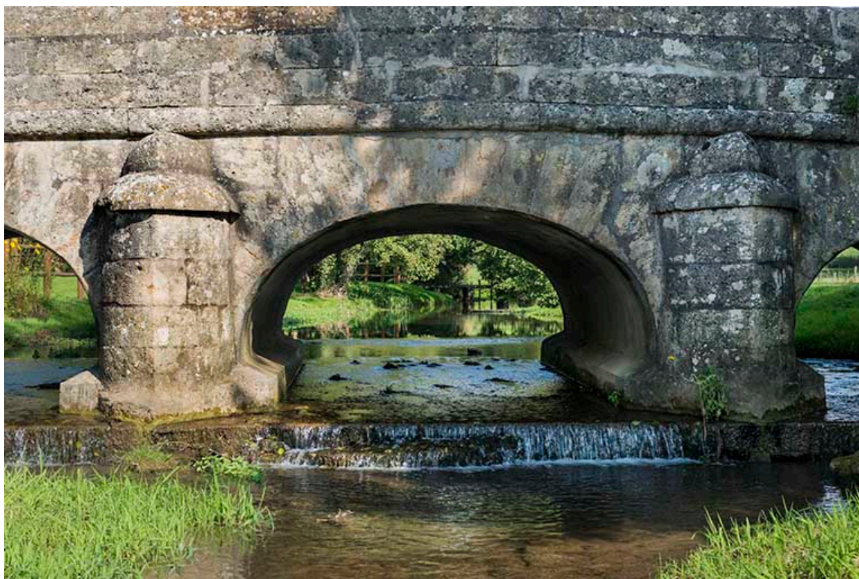
La voûte centrale.
