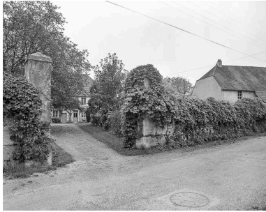
Vue d'ensemble depuis la rue. Phot. Dominique Dominguez IVR43_19807000179X
