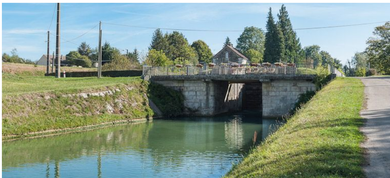
Le pont vu d'aval.
