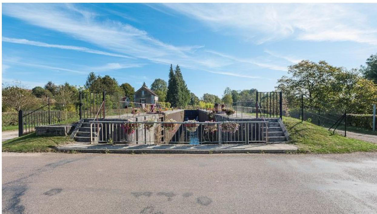
Le double sas vu du pont.
