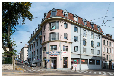
Vue d'ensemble depuis le haut de l'avenue Carnot. Phot. Jérôme Mongreville IVR43_20172501112NUC4A
