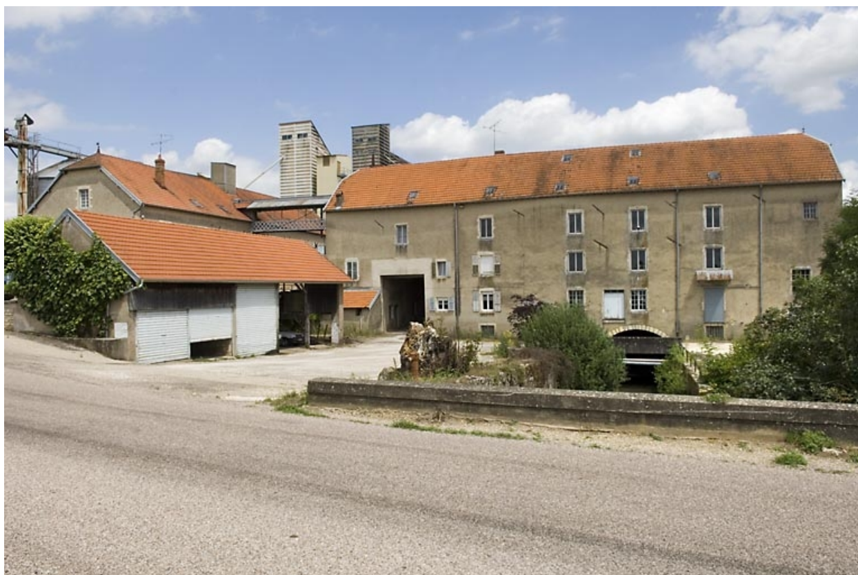
Vue d'ensemble depuis la route, à l'ouest.
