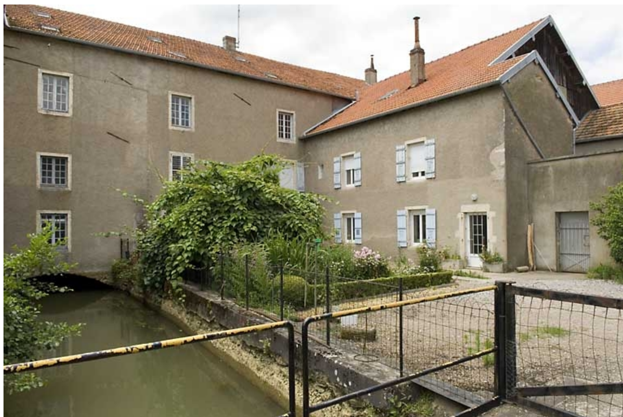
Façade postérieure et canal d'amenée.
