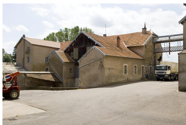
La minoterie vue de trois quarts arrière. Phot. Jérôme Mongreville IVR43_20087000696NUC2A
