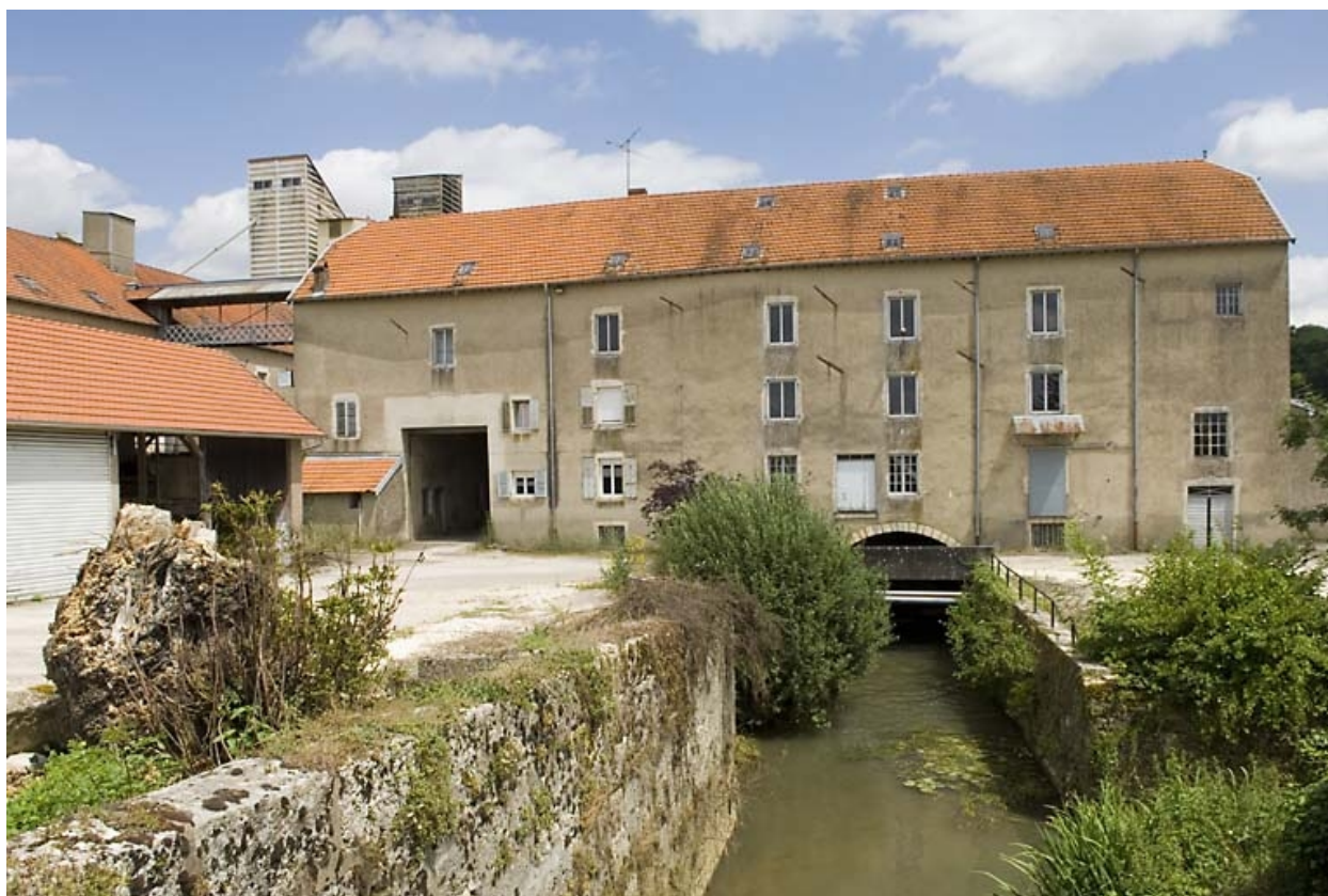
Façade antérieure de la minoterie.
