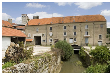
Façade antérieure de la minoterie. Phot. Jérôme Mongreville IVR43_20087000695NUC2A
