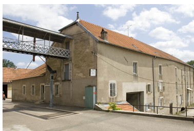
La minoterie vue de trois quarts gauche. Phot. Jérôme Mongreville IVR43_20087000699NUC2A
