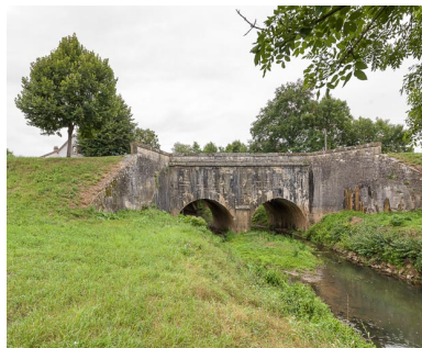
Vue d'ensemble, rive gauche. Phot. Pierre-Marie Barbe-Richaud IVR26_20175800222NUC2AQ
