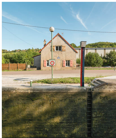
Vue de la maison éclusière. Phot. Pierre-Marie Barbe-Richaud IVR26_20177100401NUC2A
