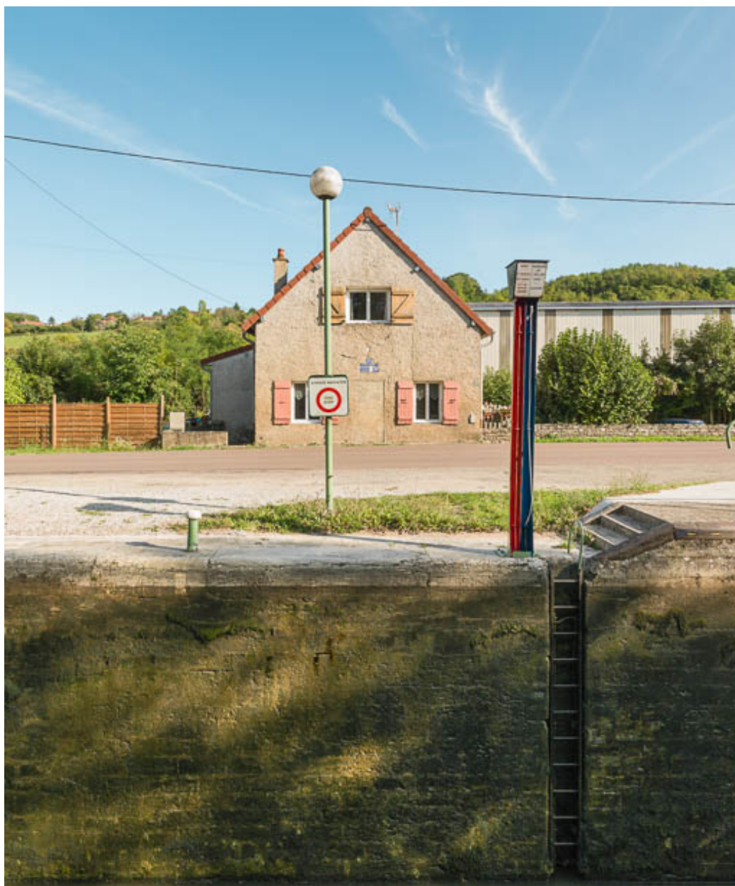
Vue de la maison éclusière.
