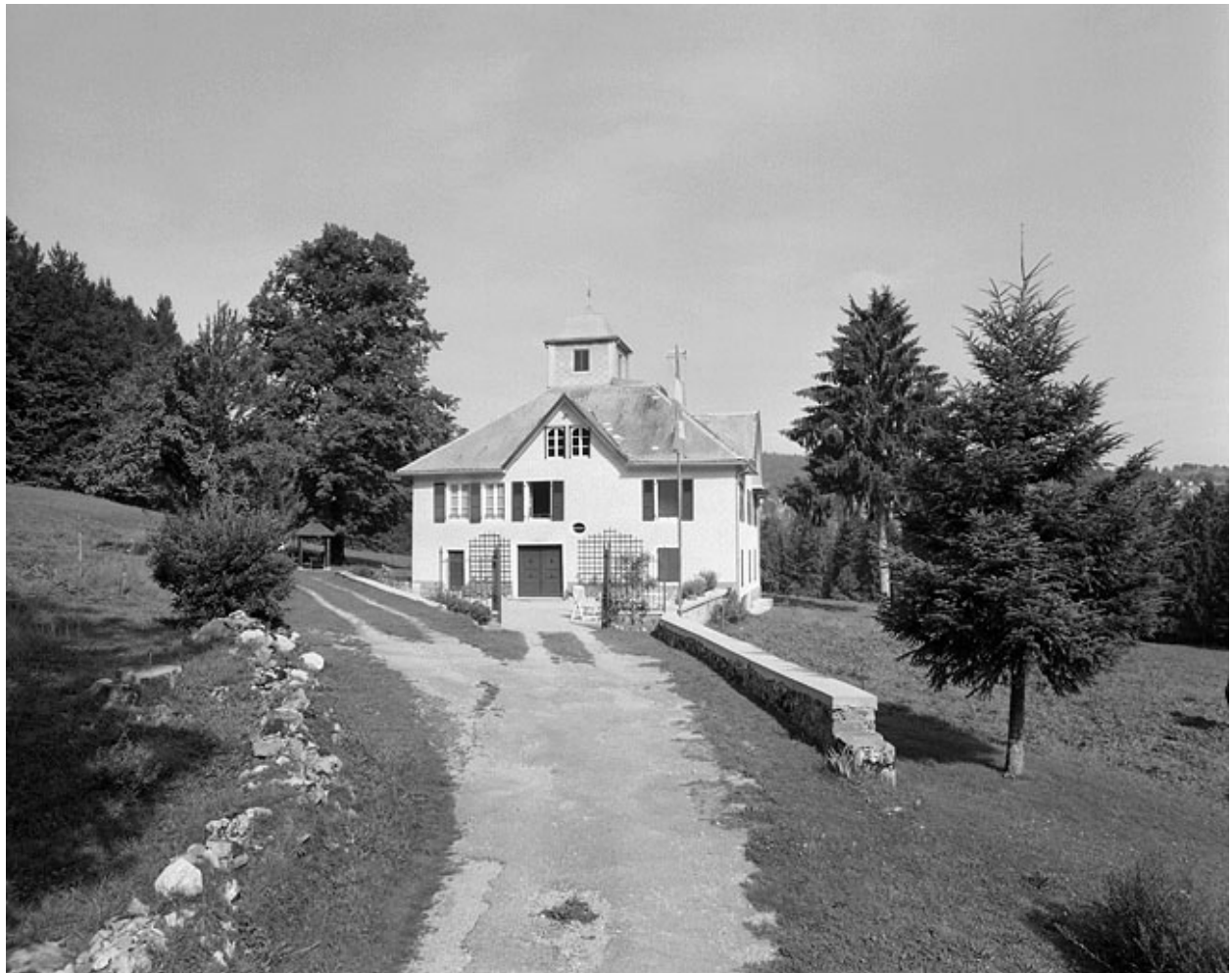
Façade antérieure, vue éloignée.
