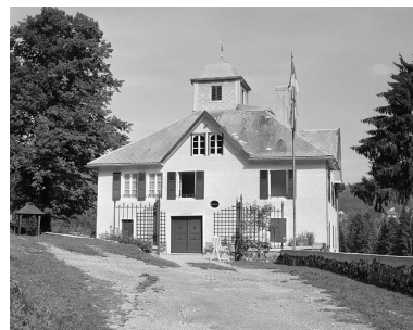
Façade antérieure. Phot. Jérôme Mongreville IVR43_20003900470X
