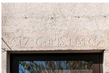
Ferme : linteau avec chrisme, initiales et date 1746. Phot. Jérôme Mongreville IVR43_20152502229NUC4A
