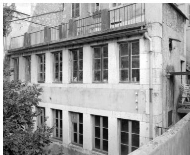
Première usine depuis le sud. Phot. Jérôme Mongreville IVR43_19923900765X
