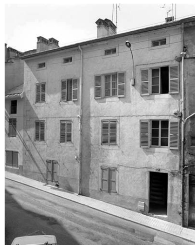
Façade antérieure de l'immeuble. Phot. Jérôme Mongreville IVR43_19923900766X
