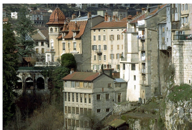
Vue d'ensemble depuis le sud. Phot. Laurent Poupard IVR43_19923901407ZA
