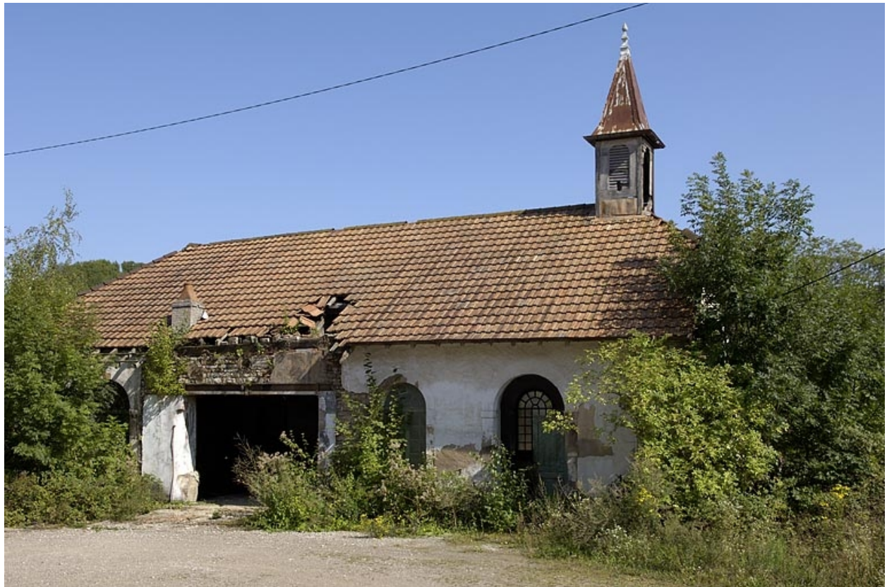
Salle des machines et atelier de réparation.
