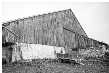
Façade postérieure Phot. Gilbert Poinot IVR43_19752501498Z
