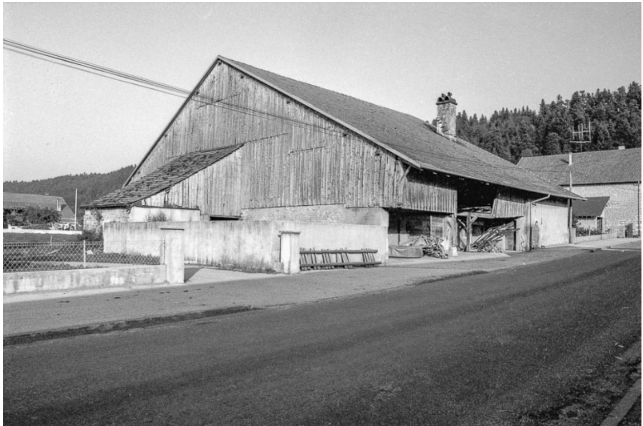
Façades postérieure et latérale gauche.
