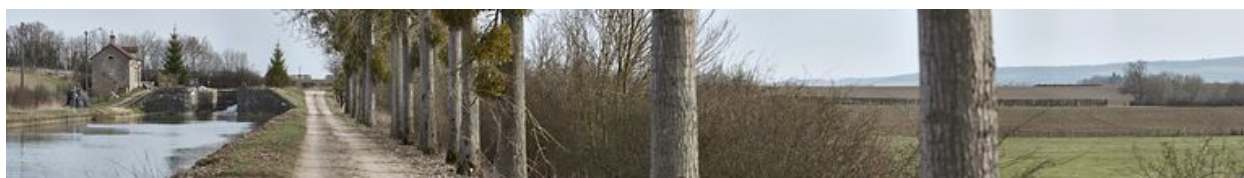
Le site d'écluse vu d'aval. Alignement d'arbres.
