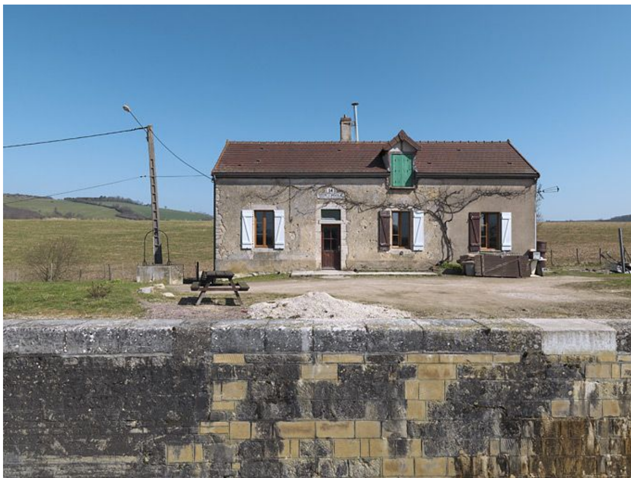
La maison éclusière de face. Puits.
