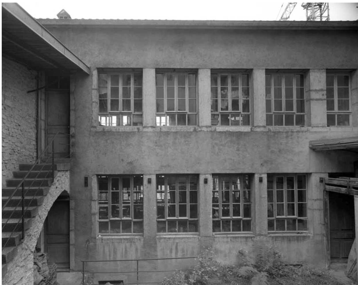
Façade antérieure de l'usine.
