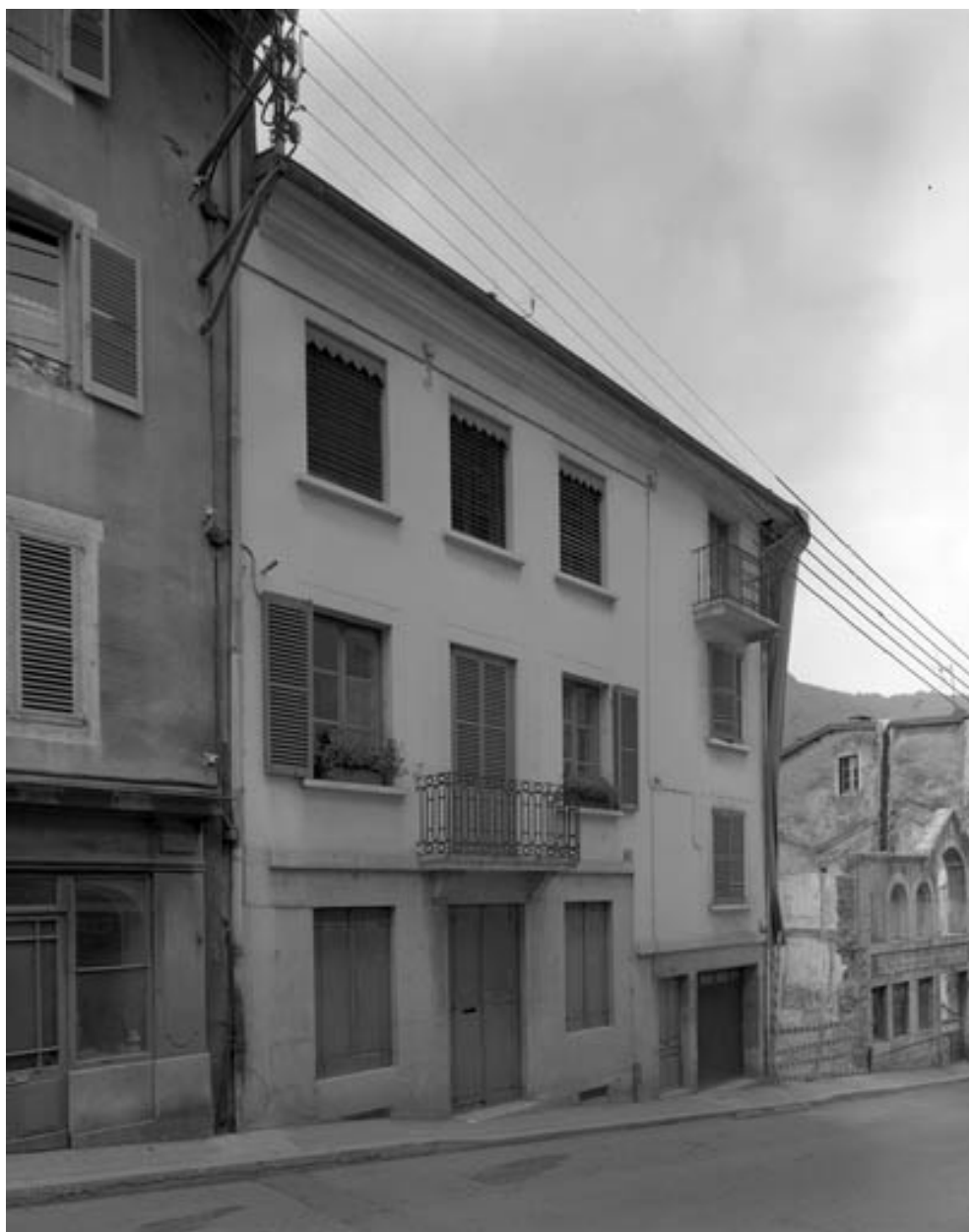
Façade antérieure du logement patronal.
