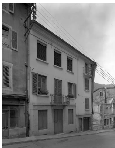
Façade antérieure du logement patronal.
