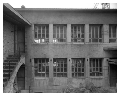
Façade antérieure de l'usine.
