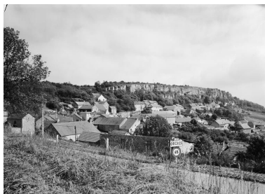
Vue d'ensemble du hameau. Phot. Jean-Luc Duthu IVR26_19802100422V
