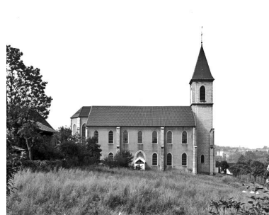
Elévation latérale gauche. Phot. Yves Sancey IVR43_19829000100V
