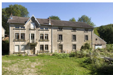
Façade antérieure. Phot. Jérôme Mongreville IVR43_20067000753NUCA
