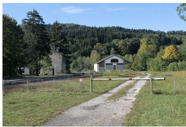
Vue d'ensemble, depuis le nord. Phot. Yves Sancey IVR43_20043900203ZA
