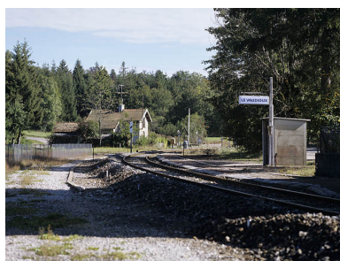
Quai des voyageurs et voie, vers le côté Andelot-en-Montagne. Phot. Yves Sancey IVR43_20043900195XA
