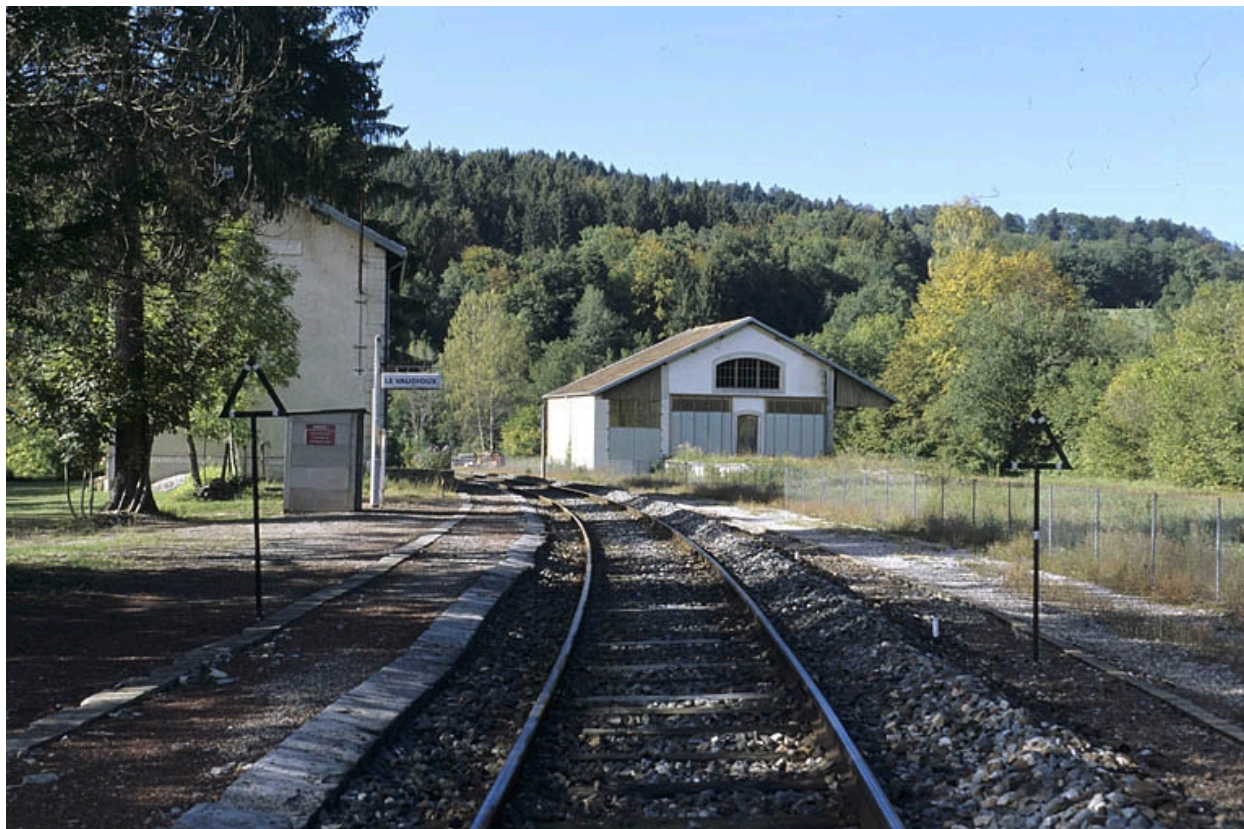
Quai des voyageurs et voie, depuis le côté Andelot-en-Montagne.
