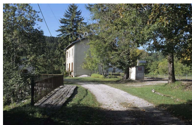
Bâtiment des voyageurs depuis le chemin d'accès, au nord-est. Phot. Yves Sancey IVR43_20043900197ZA
