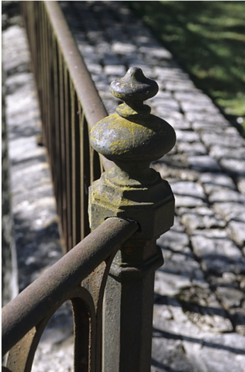
Motif d'amortissement d'un potelet du garde-corps.
