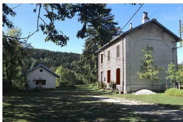
Façade antérieure du bâtiment des voyageurs, de trois quarts droite. Phot. Yves Sancey IVR43_20043900199ZA
