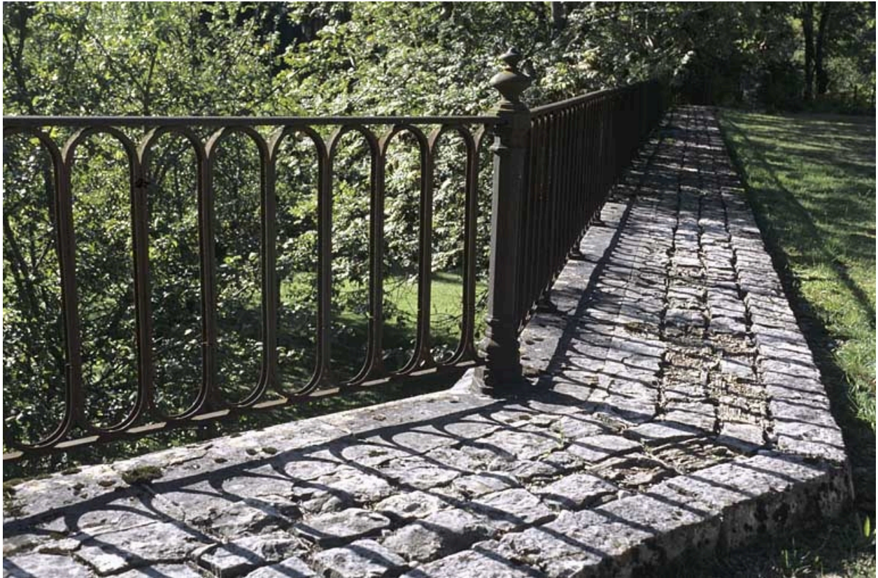
Garde-corps métallique de la cour des voyageurs.
