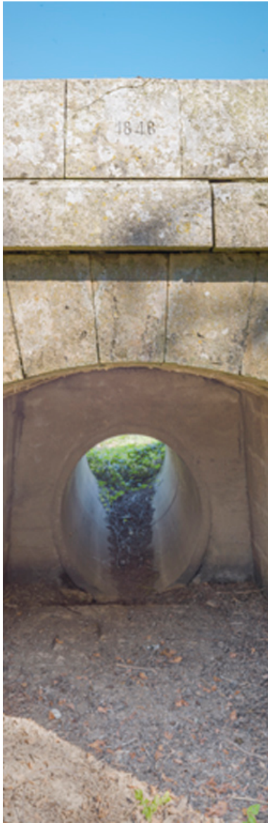
Détail de la maçonnerie en pierre de taille, particulièrement soignée.
