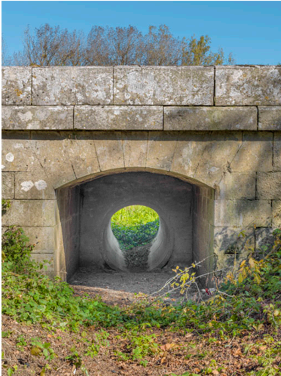
Vue rapprochée de l'arc surbaissé et de la buse.
