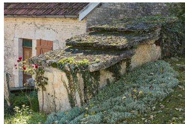
Détail de la toiture. Phot. Pierre-Marie Barbe-Richaud IVR26_20222100958NUC4A
