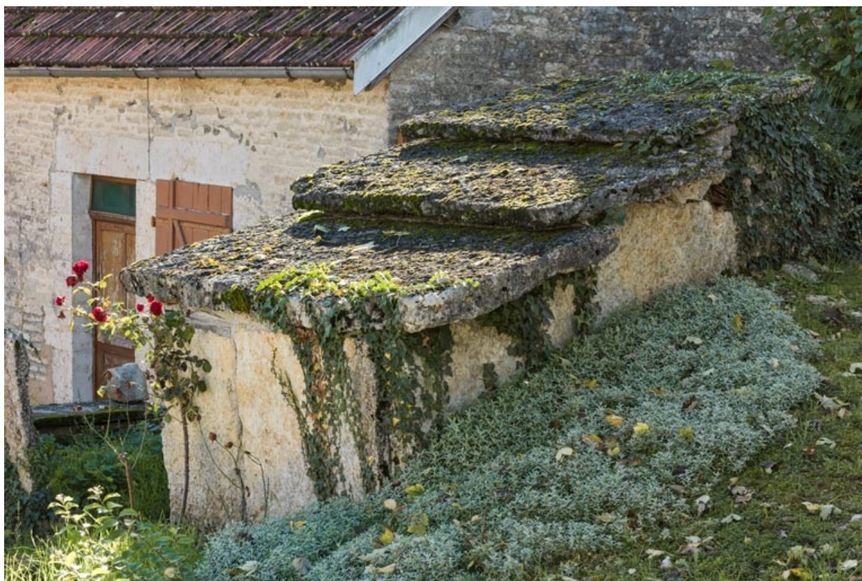
Détail de la toiture.
