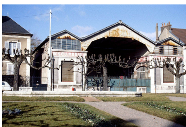
Façade antérieure de l'usine. Phot. Laurent Poupard IVR43_19893900188ZA
