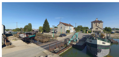
La cale sèche. Phot. Thierry Kuntz IVR26_20112103355NUC4A
