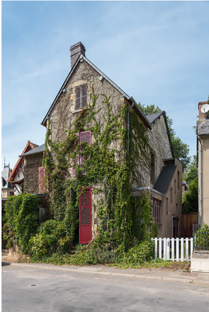
Façade principale sur la rue des Caves, état actuel.
