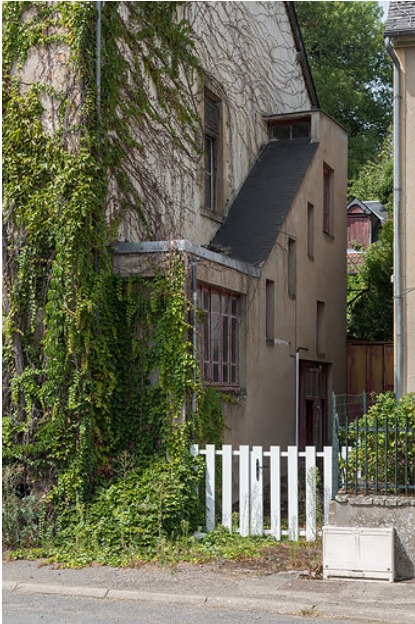
Escalier droit hors-œuvre construit contre le pignon nord permettant d'accéder à l'étage.
