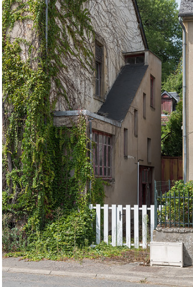
Escalier droit hors-œuvre construit contre le pignon nord permettant d'accéder à l'étage. Phot. Pierre-Marie Barbe-Richaud IVR26_20195800680NUC4A
