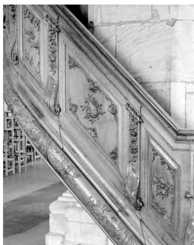
Détail : panneau de la rampe. Phot. Yves Sancey IVR43_19742500631X
