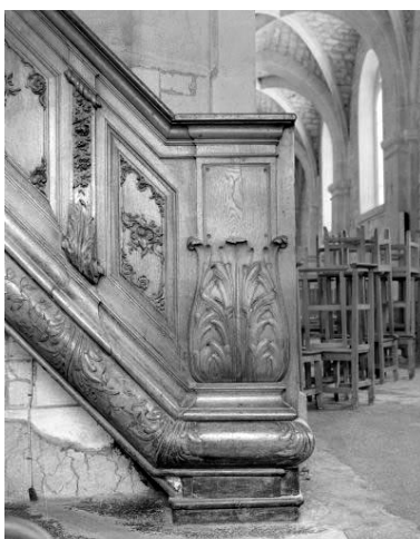
Détail : le départ de la rampe. Phot. Yves Sancey IVR43_19742500633X
