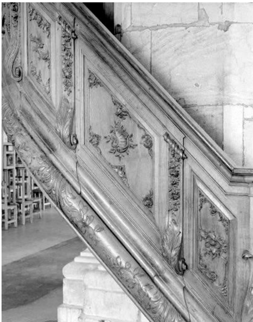
Détail : panneau de la rampe.
