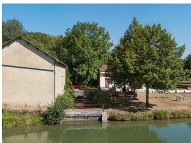
Détail d'un déversoir en aval du port.
