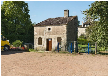
L'abri des ouvriers : vue de 3/4. Phot. Pierre-Marie Barbe-Richaud IVR26_20135800455NUC4AQ
