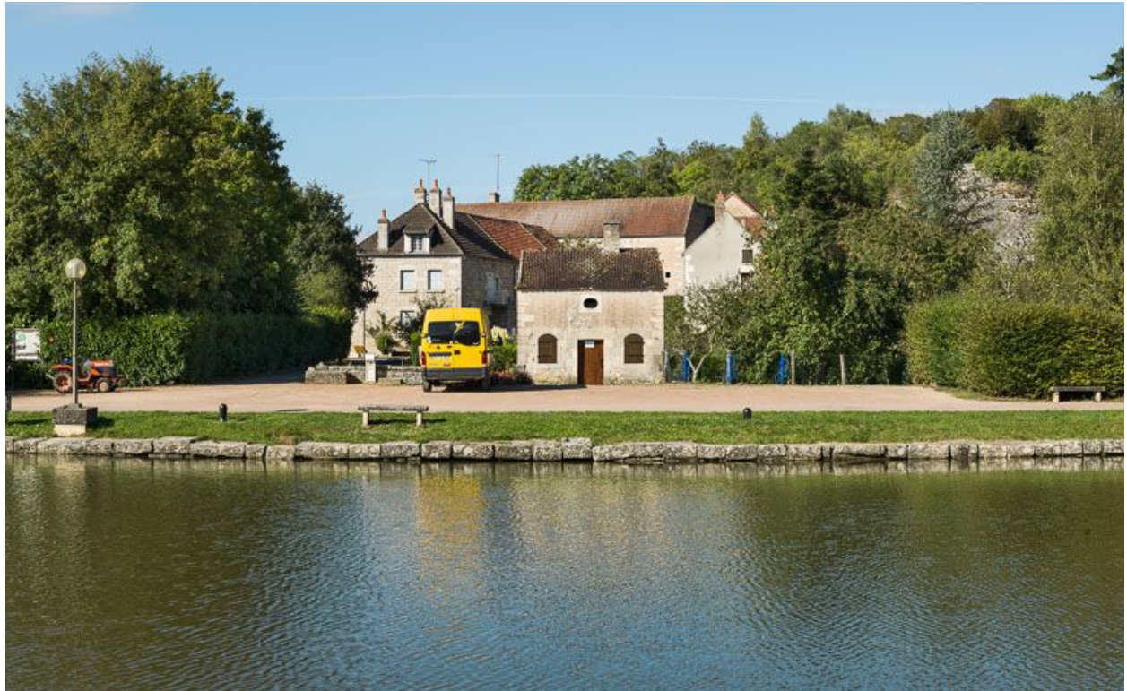
L'abri des ouvriers : vue de face.
