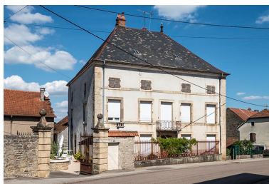
La façade antérieure. Phot. Jérôme Mongreville IVR43_20177001303NUC4A
