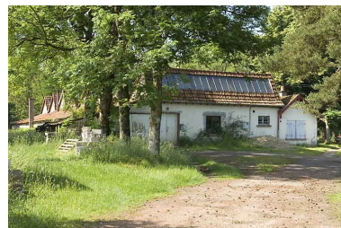
Vue d'ensemble depuis la route. Phot. Jérôme Mongreville IVR43_20077000175NUCA
