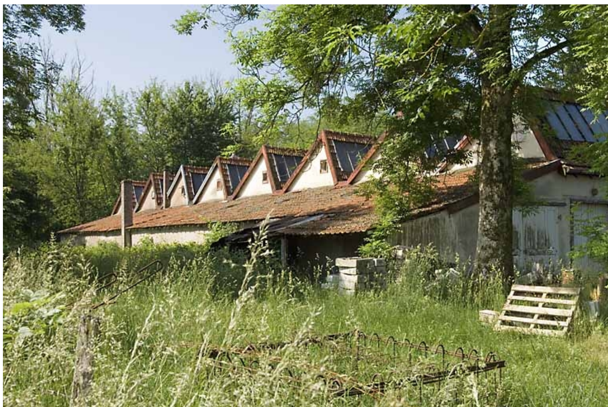
Pignons ouest de l'atelier de fabrication.
