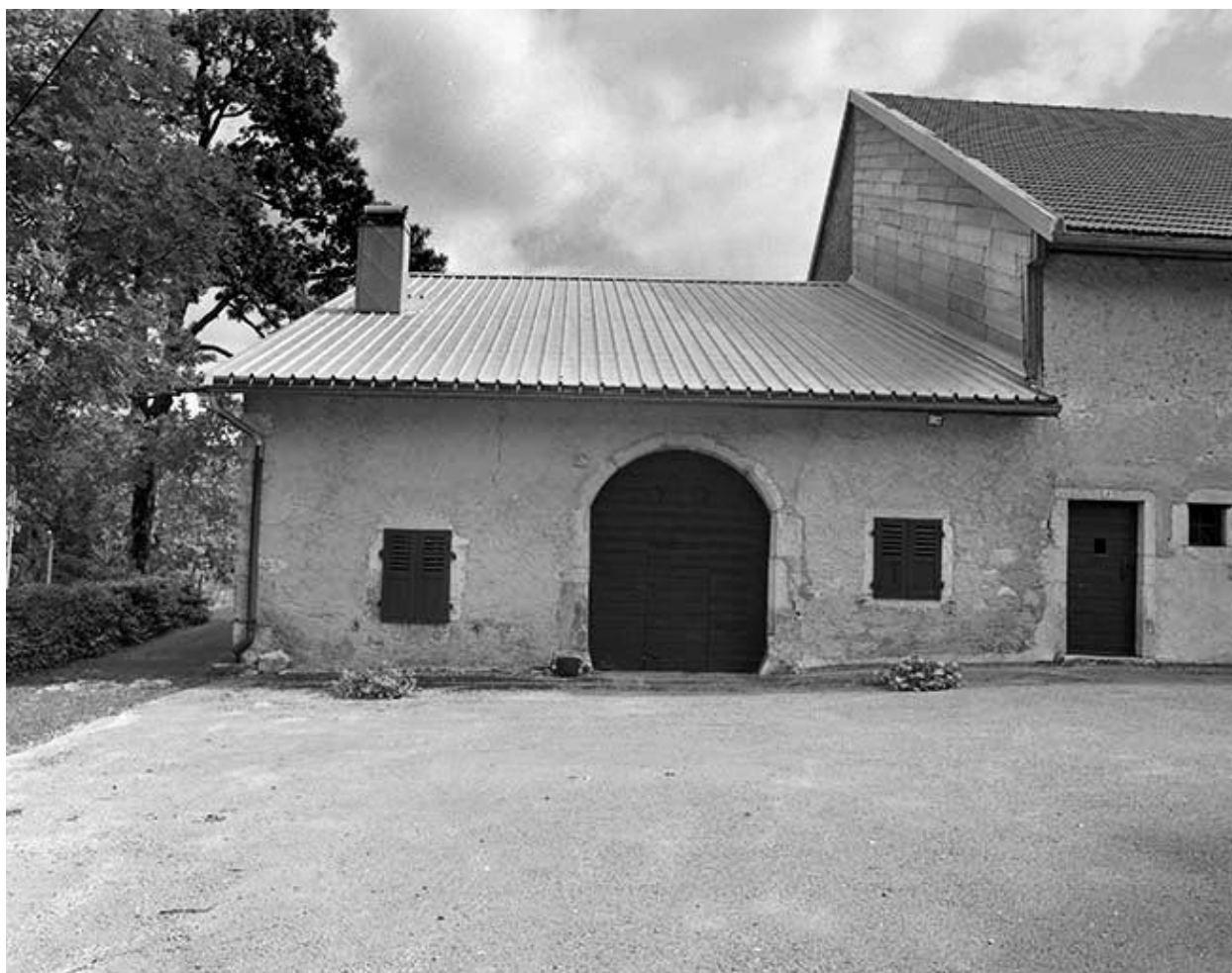
Façade postérieure de la ferme de droite.
