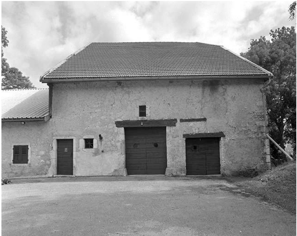
Façade postérieure de la ferme de gauche.
