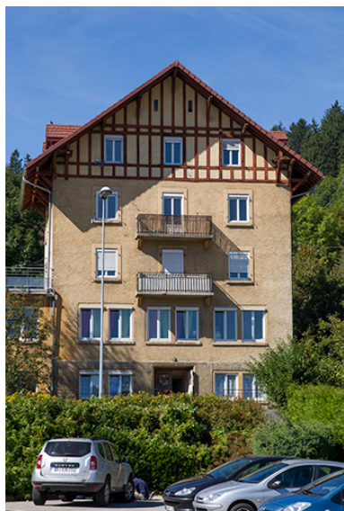
Façade antérieure. Phot. Yves Sancey IVR43_20132502325NUC2A
