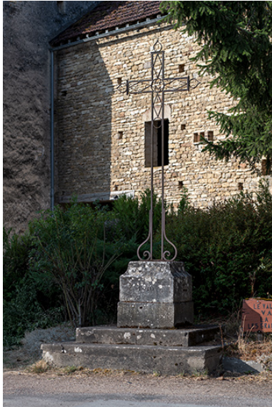
L'ensemble de la croix. Phot. Nicolas Waltefaugle IVR26_20268900353NUC4A
