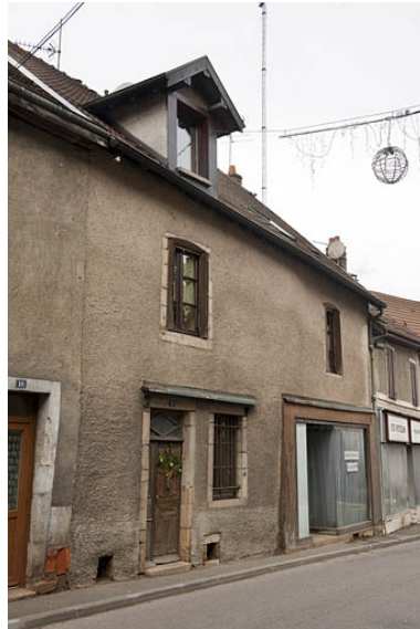
Maison au 8 Grande Rue (2010 AL 45). Phot. Jérôme Mongreville IVR43_20112502930NUC4A
