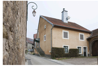
Maison au 4 rue des Gratteris (2010 AK 118) : façade latérale droite. Phot. Jérôme Mongreville IVR43_20112502928NUC4A
