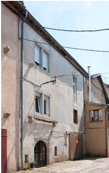
Ferme au 10 Grande Rue (2010 AL 46) : façade postérieure (rue Basse). Phot. Jérôme Mongreville IVR43_20102501047NUC4A
