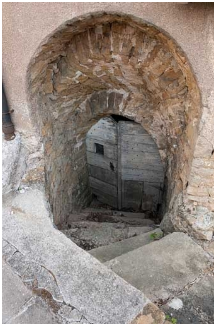
Entrée de cave de la maison au 10 rue de la Grande Côte (2010 AL 77).
