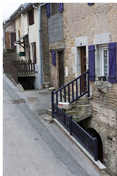
Entrées de cave des maisons aux 14 et 16 rue des Gratteris (2010 AK 110 et 111). Phot. Jérôme Mongreville IVR43_20112500341NUC4A
