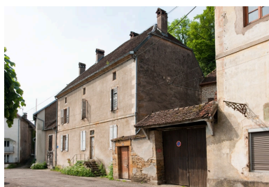
Maison au 26 rue du Vieux Moulin (2010 AL 164). Phot. Jérôme Mongreville IVR43_20102500689NUC4A
