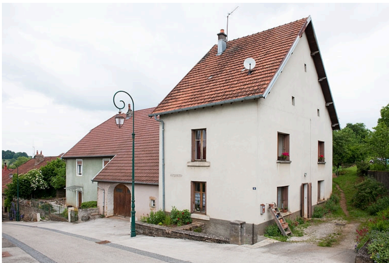
Maison et ferme aux 19 et 21 rue des Gratteris (2010 AK 55 et 58).
