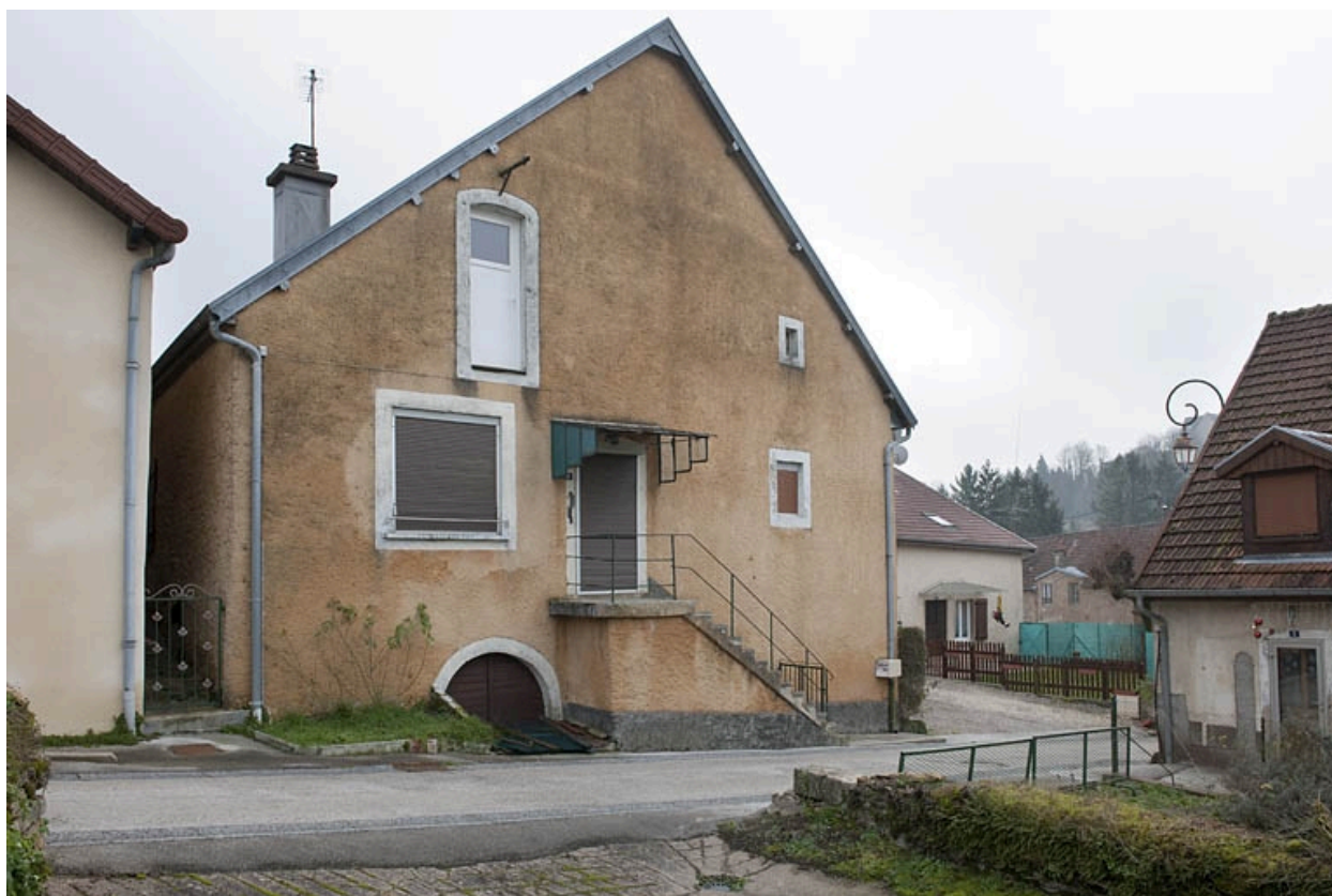
Maison au 4 rue des Gratteris (2010 AK 118) : façade antérieure.
