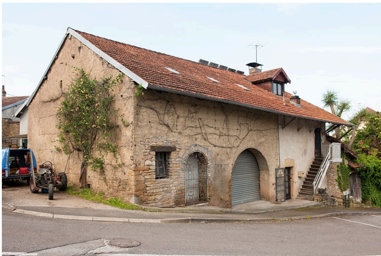
Ferme au 2 rue Maurice Demeusy (2010 AL 416).
