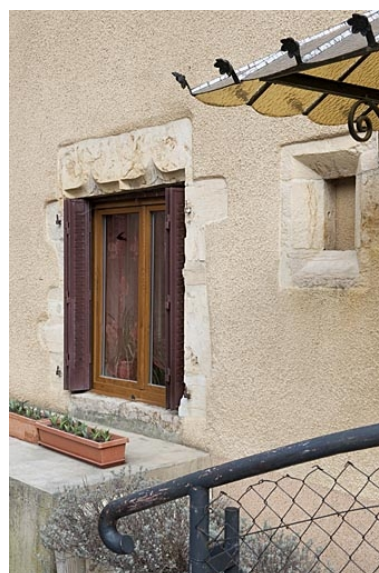
Fenêtre à linteau en arc en accolade de la maison au 12 Grande Rue (2010 AL 47). Phot. Jérôme Mongreville IVR43_20112500351NUC4A
