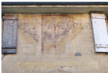
Décor peint en façade de la maison au 6 rue du Vieux Moulin (2010 AL 135) : fenêtre en trompe-l'oeil. Phot. Jérôme Mongreville IVR43_20112500320NUC4A
