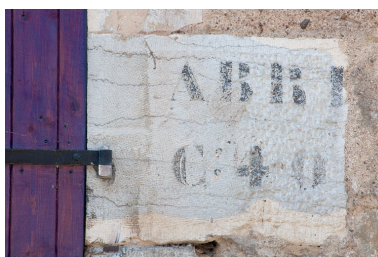
Maison au 14 rue des Gratteris (2010 AK 111) : inscription sur le piédroit de la fenêtre. Phot. Jérôme Mongreville
