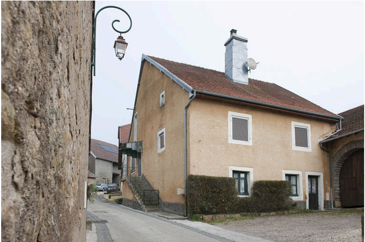
Maison au 4 rue des Gratteris (2010 AK 118) : façade latérale droite.
