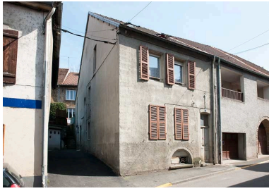
Maison au 1 Grande Rue (2010 AL 96). Phot. Jérôme Mongreville IVR43_20102500405NUC4A
