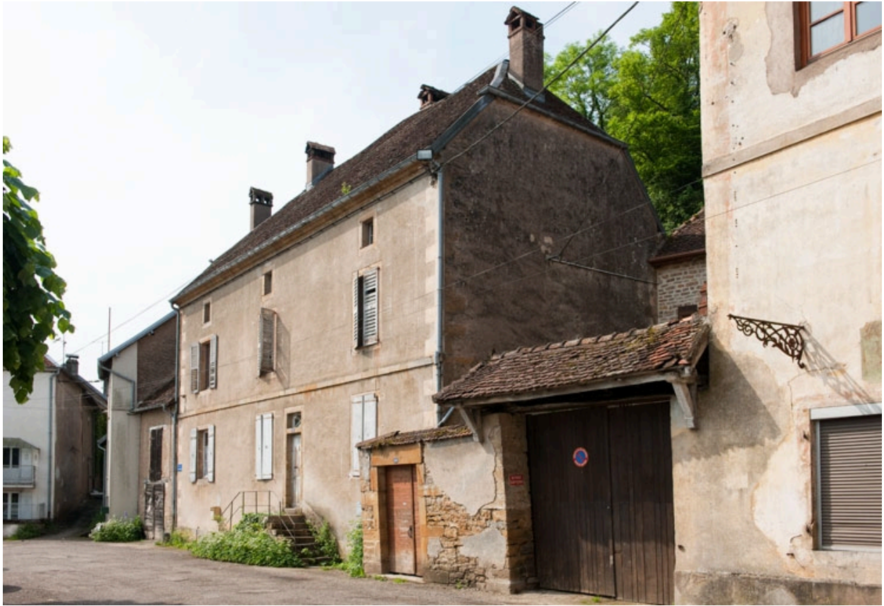
Maison au 26 rue du Vieux Moulin (2010 AL 164).
