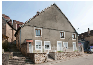
Maison au 25 Grande Rue (2010 AL 461). Phot. Jérôme Mongreville IVR43_20102500378NUC4A
