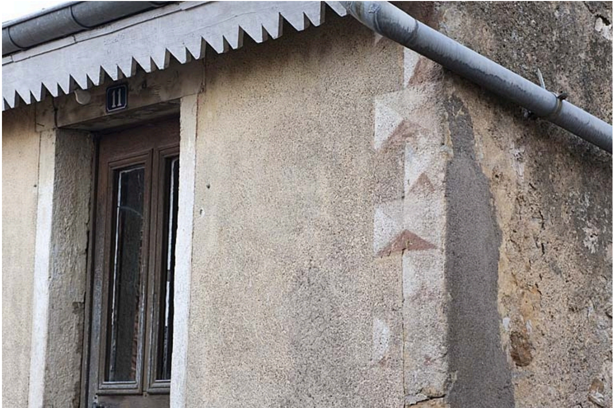
Décor en "pointe de diamant" peint en façade de la maison au 11 rue des Gratteris (2010 AK 48).
