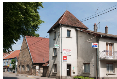
Maison au 9 rue du Vieux Moulin (2010 AK 289) et ferme au 7 (2010 AK 187). Phot. Jérôme Mongreville IVR43_20102500649NUC4A
