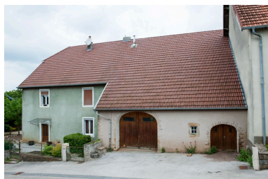
Ferme au 19 rue des Gratteris (2010 AK 55). Phot. Jérôme Mongreville IVR43_20102500637NUC4A
