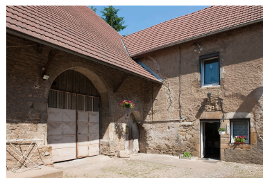
Ferme au 7 rue du Vieux Moulin (2010 AK 187) : grange et logis. Phot. Jérôme Mongreville IVR43_20102501039NUC4A
