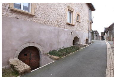
Entrées de cave de la maison à l'angle des rues de la Traverse et de l'Eglise (2010 AL 120). Phot. Jérôme Mongreville IVR43_20112500338NUC4A
