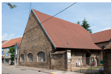
Ferme au 7 rue du Vieux Moulin (2010 AK 187) : la grange. Phot. Jérôme Mongreville IVR43_20102500648NUC4A
