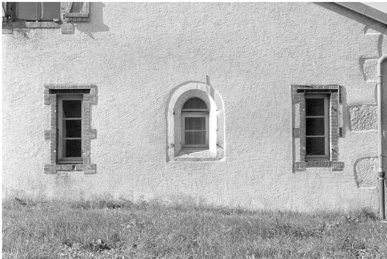
Détail des fenêtres de la fromagerie.
