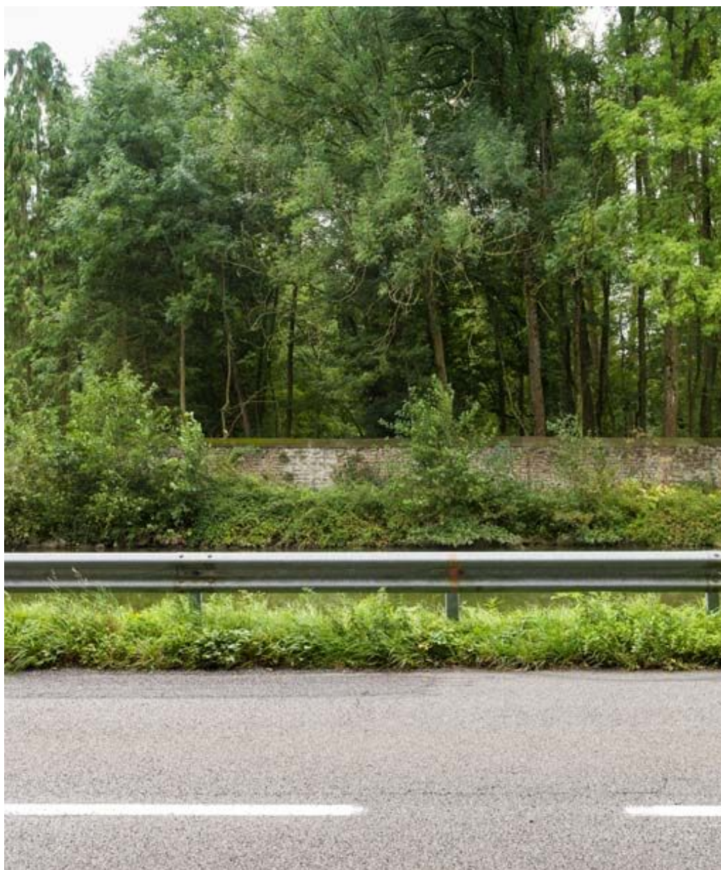
Vue de l'aqueduc.
