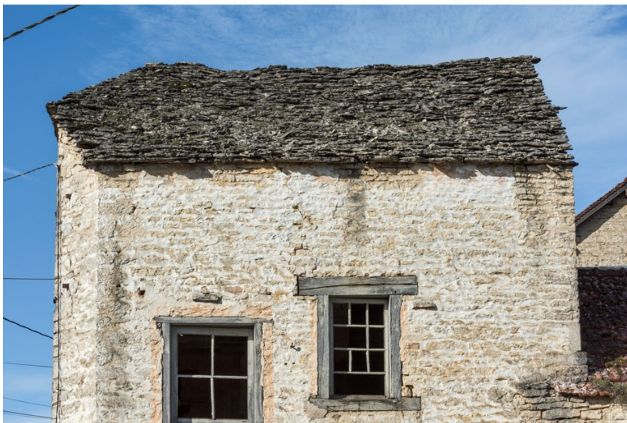
Détail de la toiture côté est.
