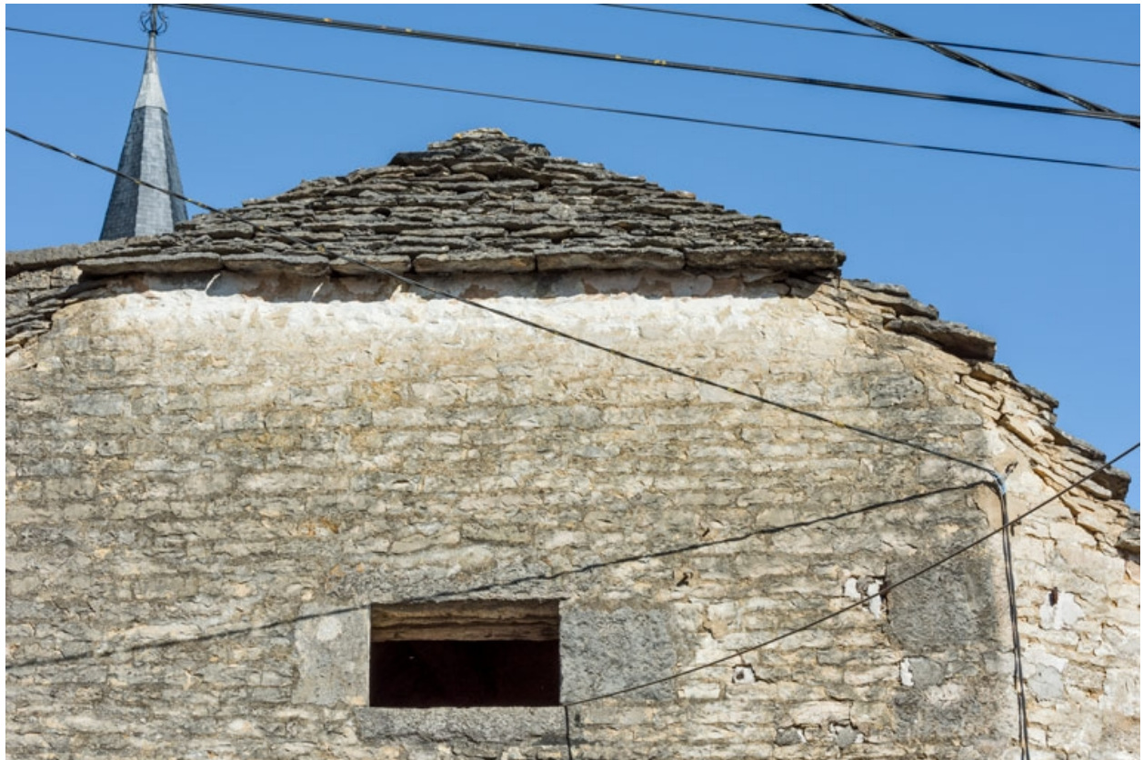
Détail de la toiture côté sud.
