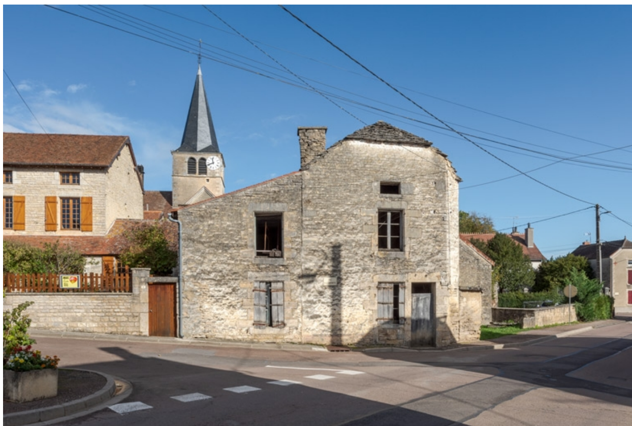
Vue d'ensemble depuis le sud.
