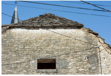
Détail de la toiture côté sud. Phot. Pierre-Marie Barbe-Richaud IVR26_20222100970NUC4A
