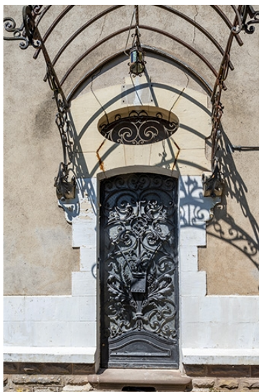
Porte d'entrée. Phot. Jérôme Mongreville IVR43_20207000562NUC4A
