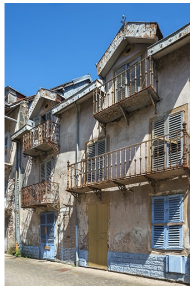
Balcons de l'ancienne maison. Phot. Jérôme Mongreville IVR43_20207000561NUC4A
