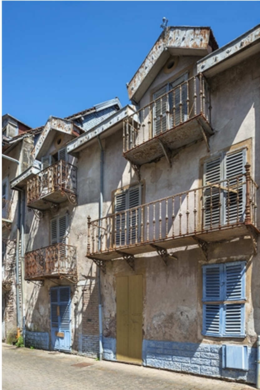
Balcons de l'ancienne maison.
