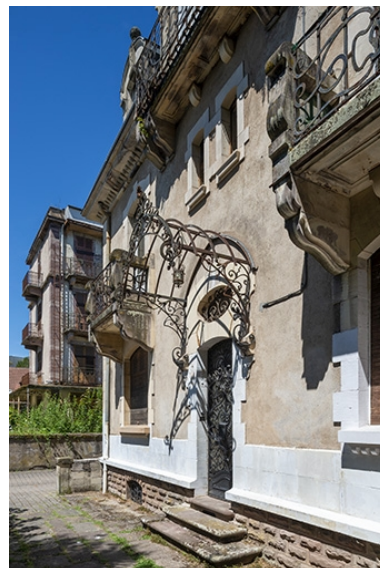
Porte d'entrée. Phot. Jérôme Mongreville IVR43_20207000554NUC4A
