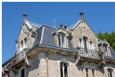
Toiture et lucarnes. Phot. Jérôme Mongreville IVR43_20207000565NUC4A
