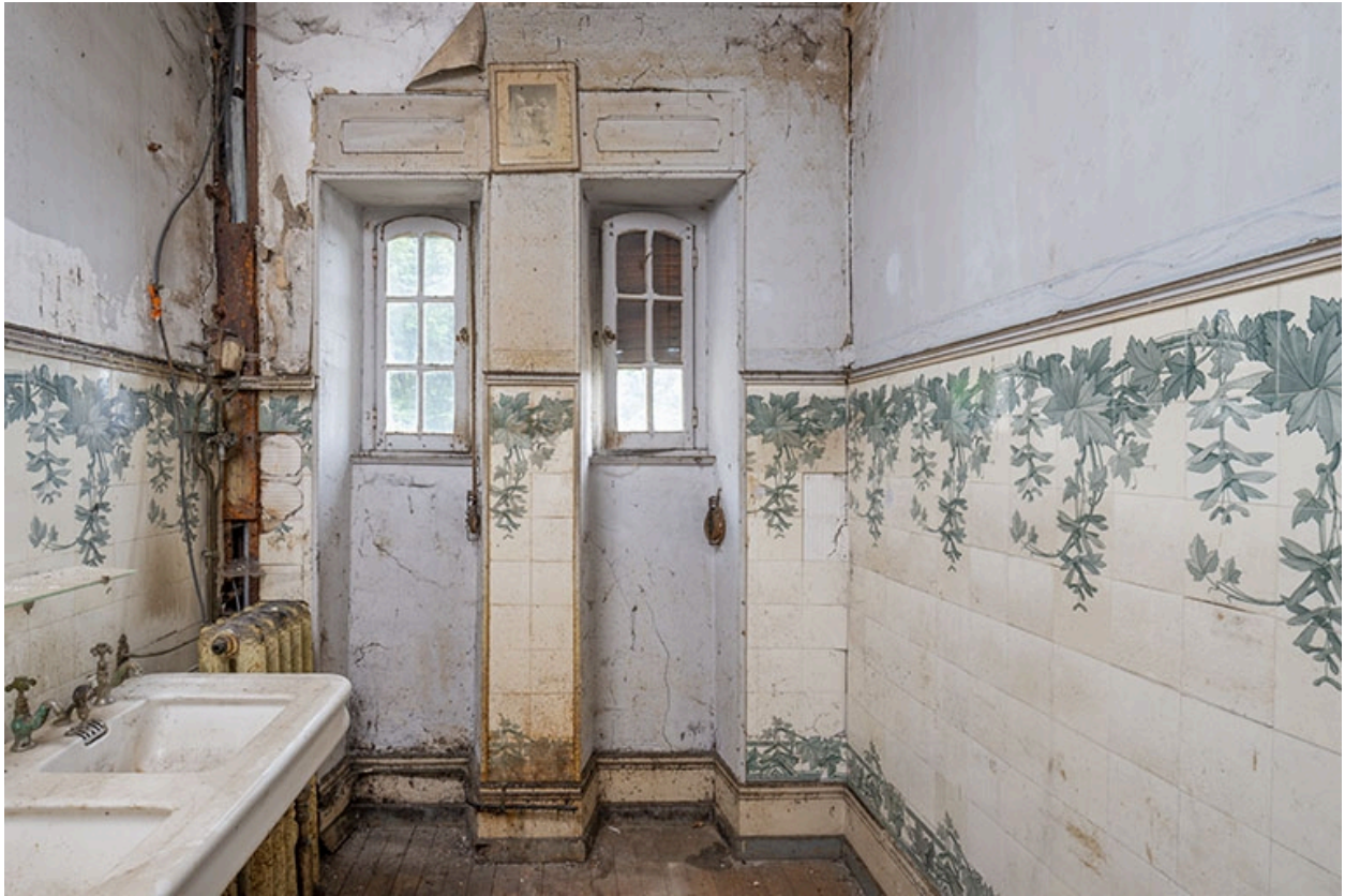
Salle de bain du premier étage, fenêtres ouvrant en façade sud.
