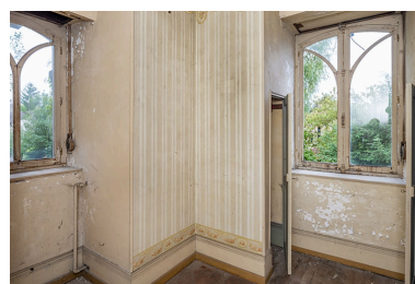
Placard de la chambre sud-est du premier étage. Phot. Jérôme Mongreville IVR43_20207000643NUC4A
