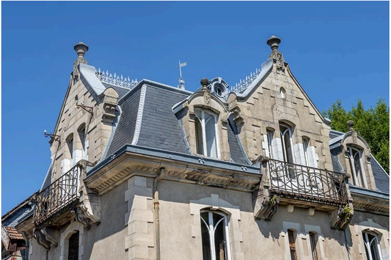
Toiture et lucarnes.
