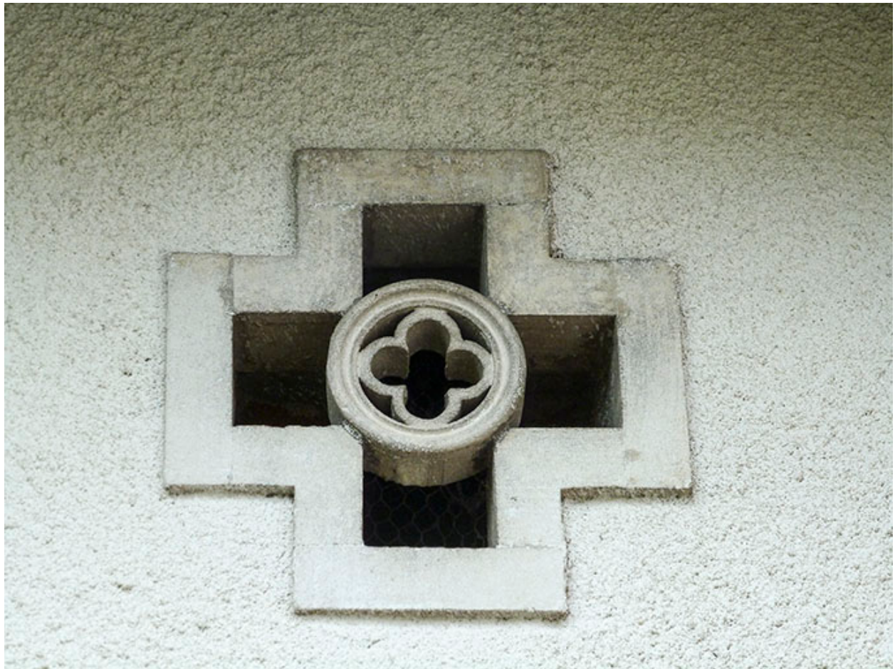
Remise : baie cruciforme de l'étage de comble.
