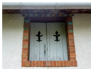
Remise : baie de l'étage de comble. Phot. Jérôme Mongreville IVR43_20167000125NUC2A
