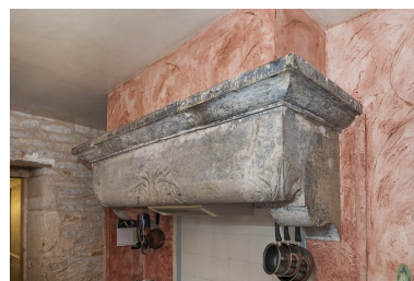
Cheminée de la cuisine.
