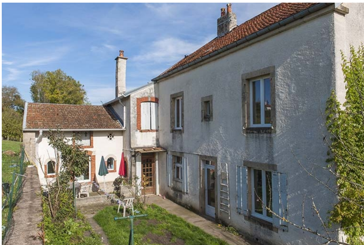
Façade postérieure et remise.
