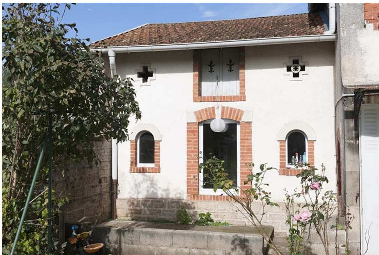
Façade antérieure de la remise.
