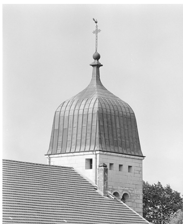
Partie supérieure de la tour-clocher. Phot. Yves Sancey IVR43_19963900881X
