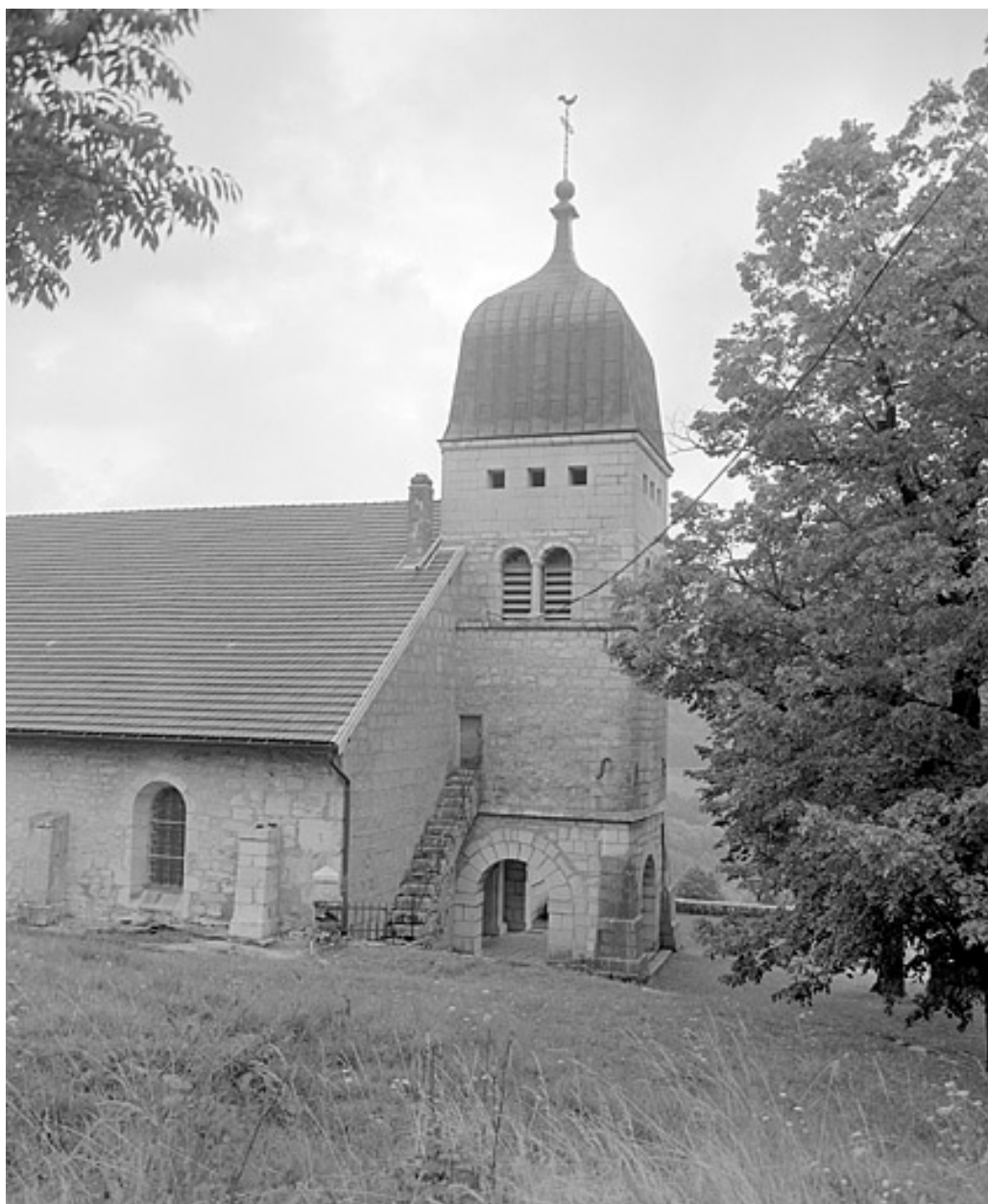
Face nord de la tour-clocher.
