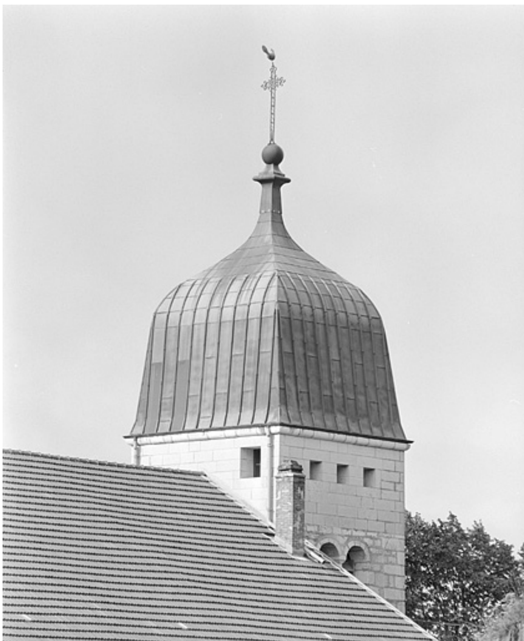
Partie supérieure de la tour-clocher.
