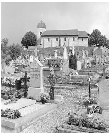
Face sud vue depuis le cimetière. Phot. Yves Sancey IVR43_19963900876X
