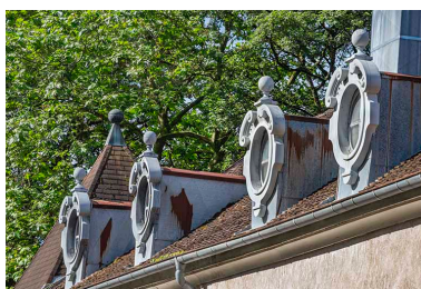
Maisons canoniales. Détail des lucarnes. Phot. Jérôme Mongreville IVR43_20243900819NUC4A
