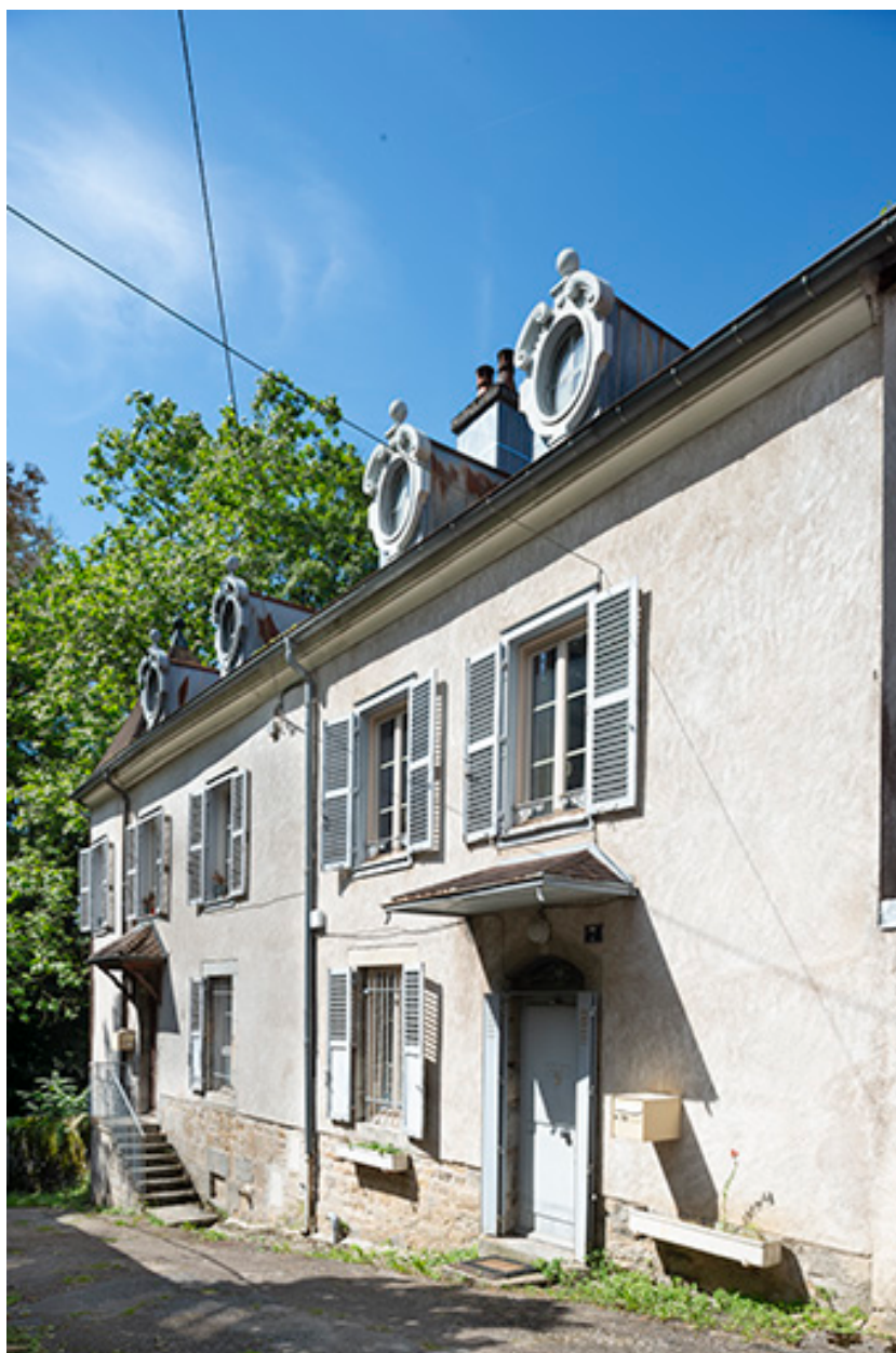
Maisons canoniales (7 escaliers de Saint-Anatoile). Façades depuis le nord-est.
