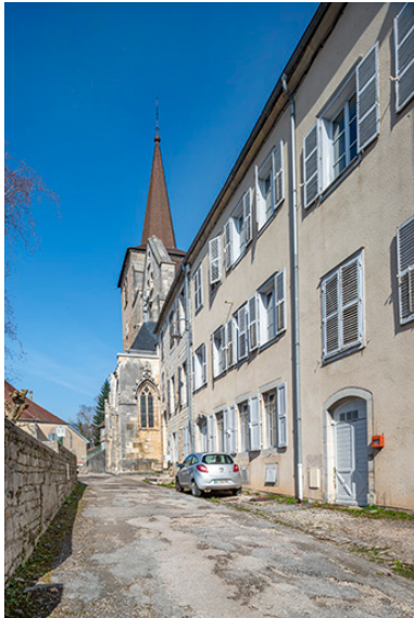
Façade ouest des bâtiments canoniaux, depuis le sud. Phot. Jérôme Mongreville IVR43_20243901121NUC4A
