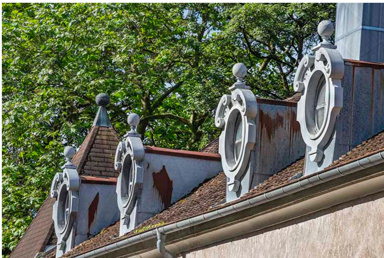
Maisons canoniales. Détail des lucarnes.
