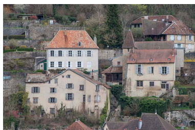
Maisons canoniales, vues depuis l'ouest. Phot. Jérôme Mongreville IVR43_20233900144NUC4A
