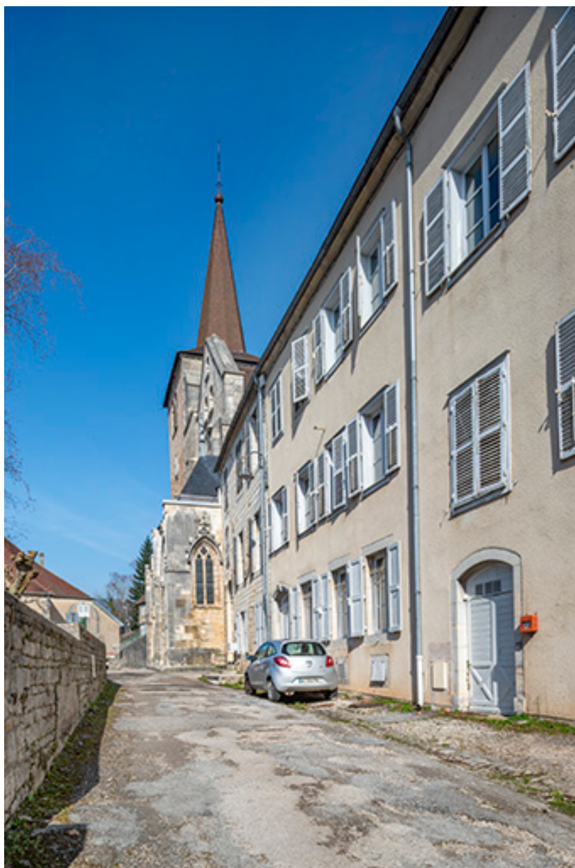
Façade ouest des bâtiments canoniaux, depuis le sud.
