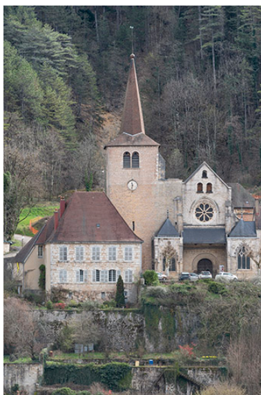
Le presbytère et l'église, depuis l'ouest. Phot. Jérôme Mongreville IVR43_20233900143NUC4A
