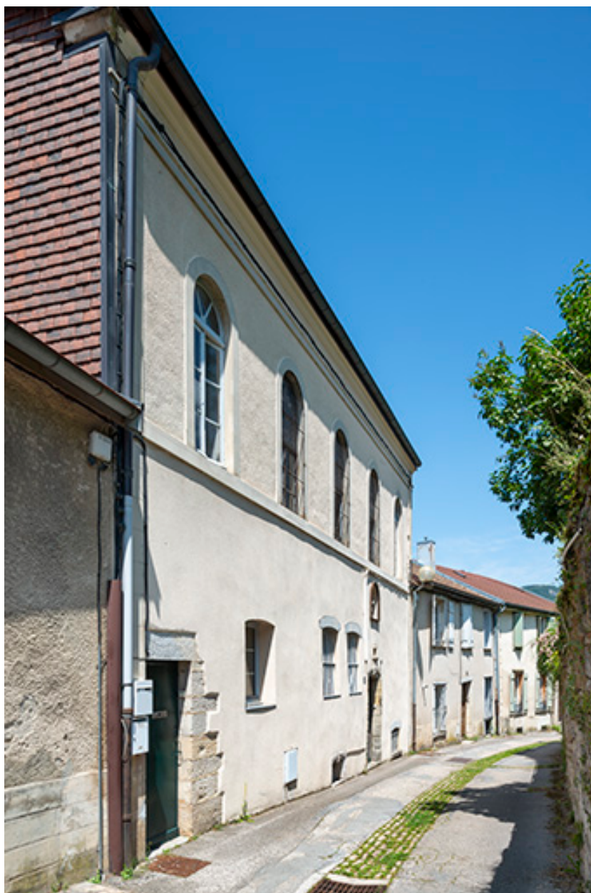
Maisons canoniales (4 à 8 rue des Claristes). Vue depuis le sud.
