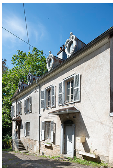
Maisons canoniales (7 escaliers de Saint-Anatoile). Façades depuis le nord-est. Phot. Jérôme Mongreville IVR43_20243900823NUC4A
