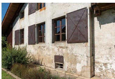
Corps sud-est et ses volets métalliques. Phot. Sonia Dourlot IVR43_20172501184NUC4A
