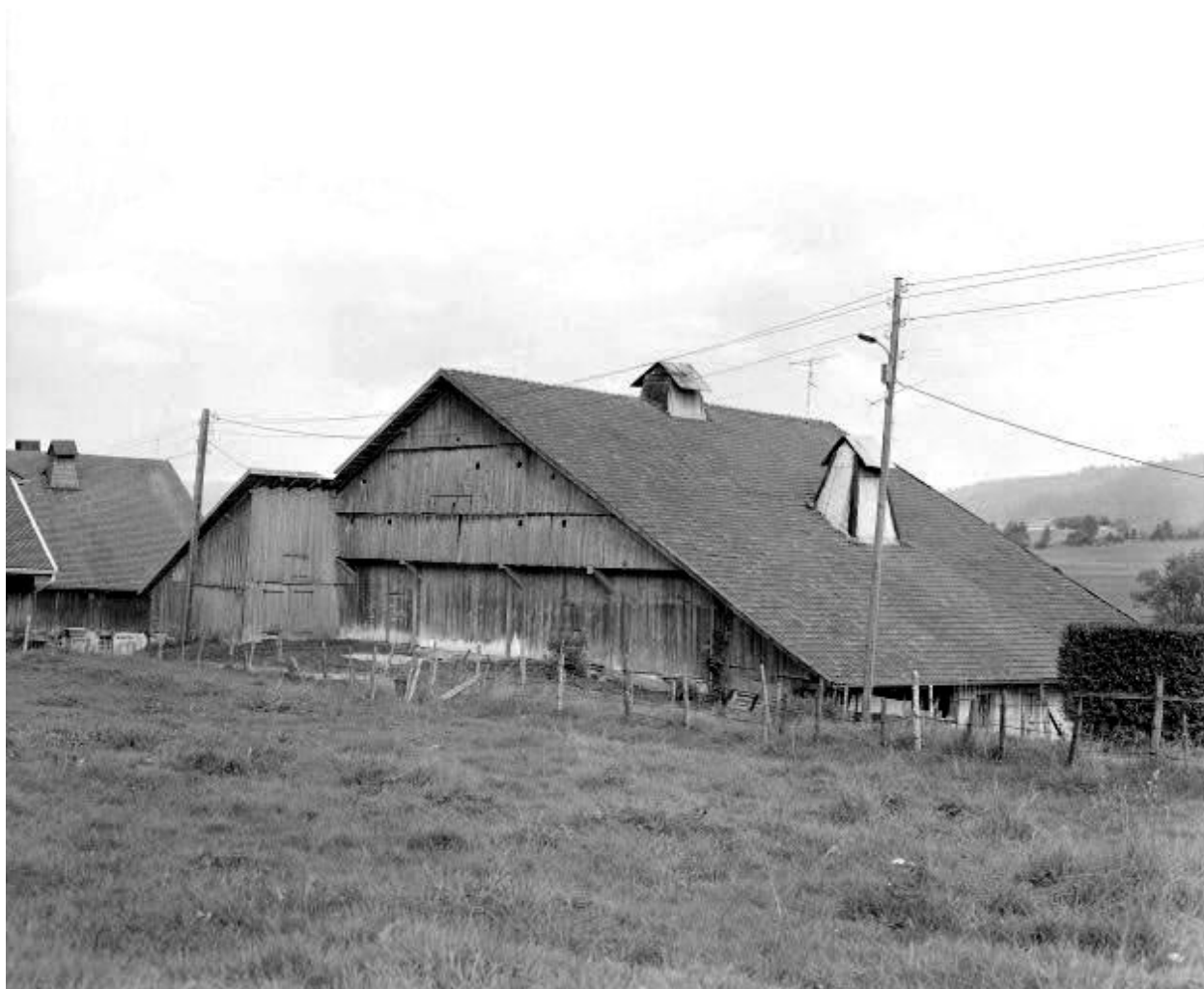
Façade ouest en 1976, de trois quarts droite.
