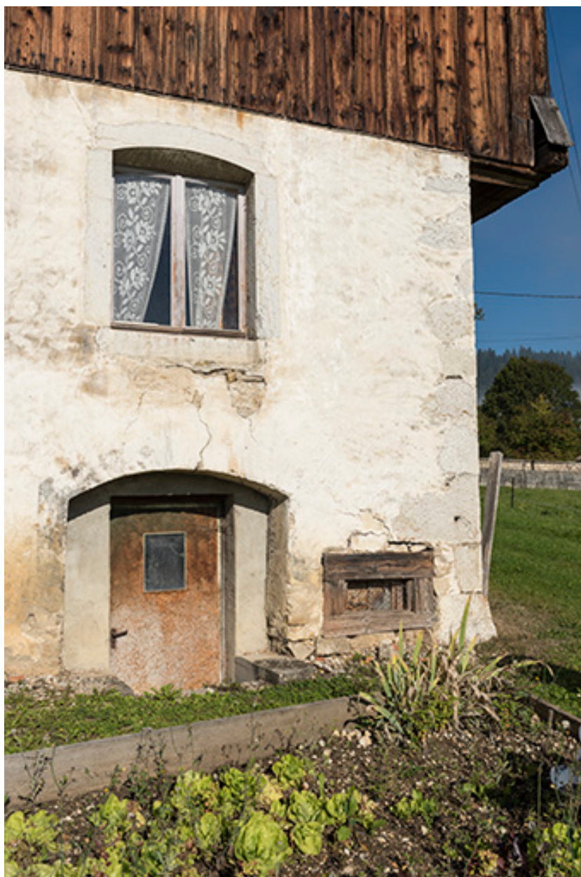
Façade est : accès au sous-sol (extension nord-est).
