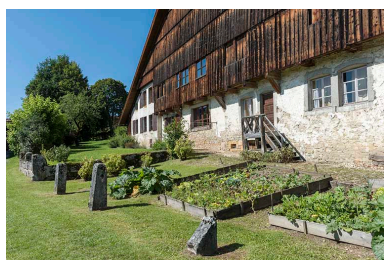
Façade est, vue en enfilade. Phot. Sonia Dourlot IVR43_20172501185NUC4A
