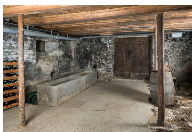
Intérieur : cave sous le corps sud-est.
