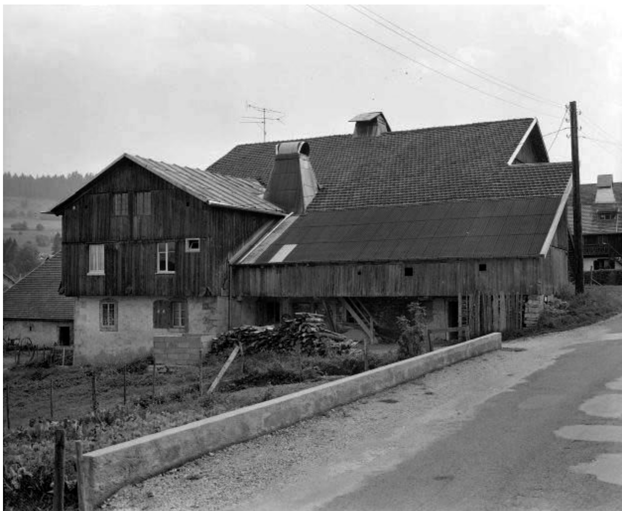
Façade nord en 1976, de trois quarts droite.
