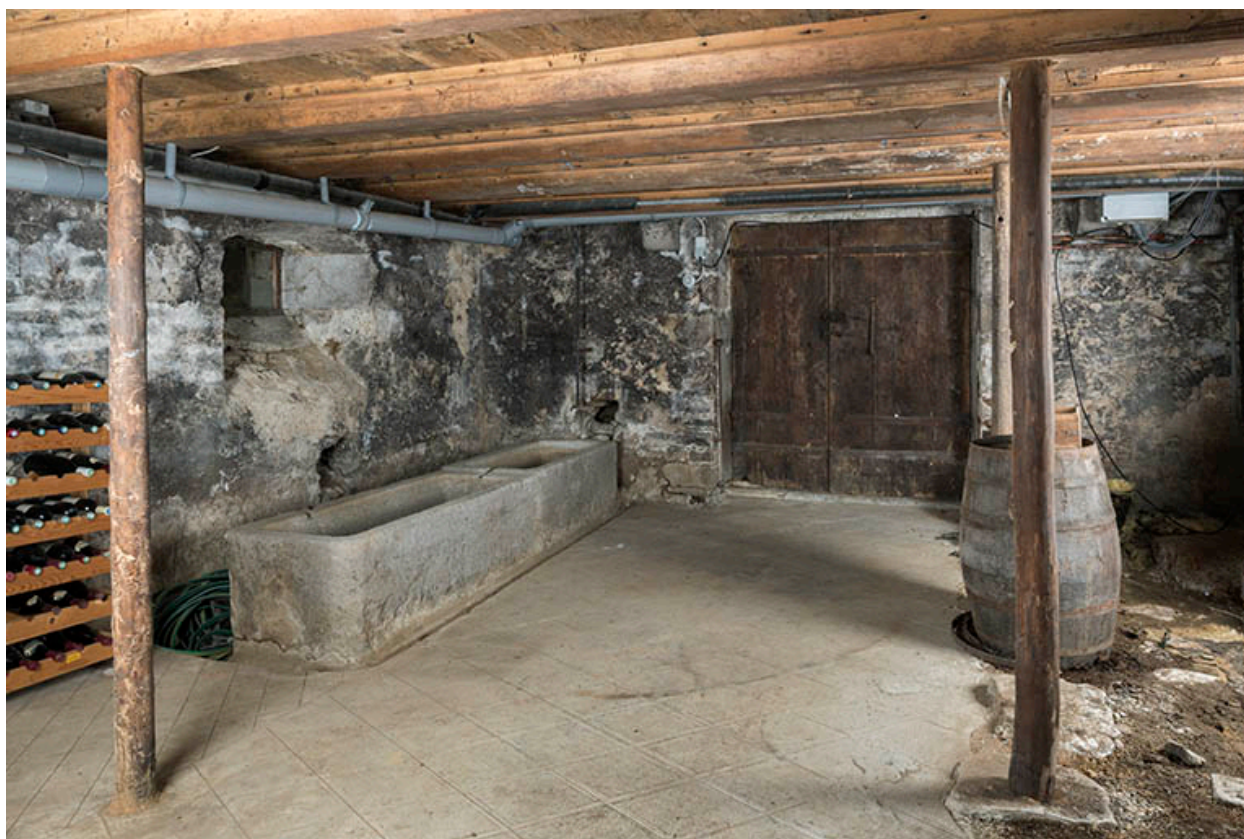
Intérieur : cave sous le corps sud-est.
