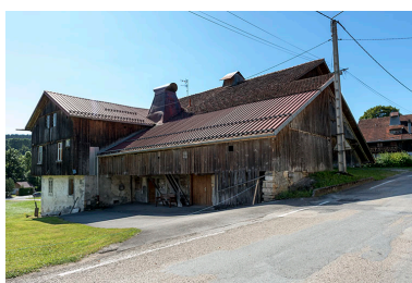
Façade nord, de trois quarts droite. Phot. Sonia Dourlot IVR43_20172501182NUC4A
