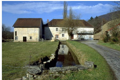
Vue d'ensemble. Phot. Jérôme Mongreville IVR43_19963900027ZA
