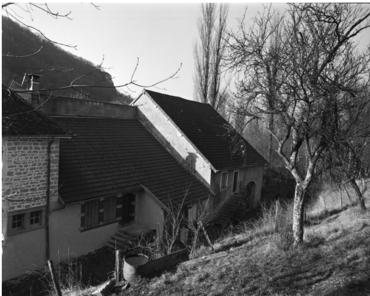
Aile nord.Logement et ferme.
