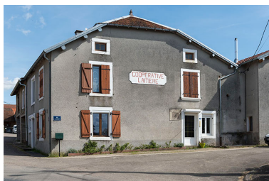
Ancienne coopérative laitière. Phot. Sonia Dourlot IVR43_20177000342NUC4A
