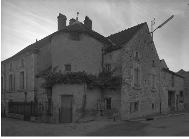
Tour ronde et maison. Façades sur rue. Phot. Michel Thierry IVR26_19748900719V
