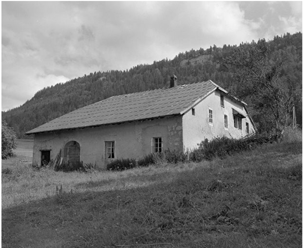
Façades postérieure et latérale gauche.
