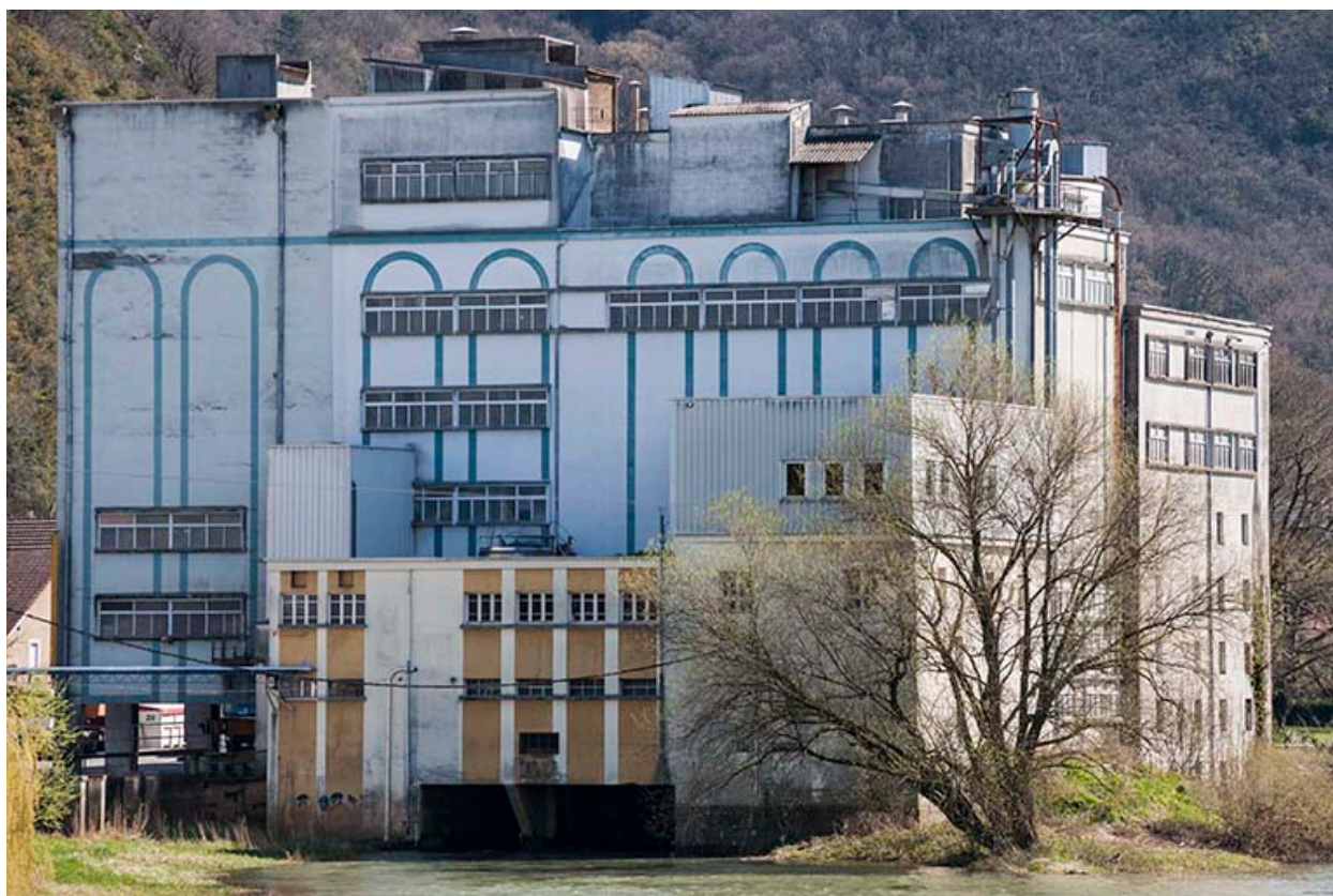
Vue rapprochée, depuis le sud-ouest.
