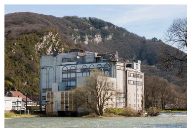
Vue de trois quarts, depuis le sud-ouest. Phot. Jérôme Mongreville IVR43_20152500985NUC4A
