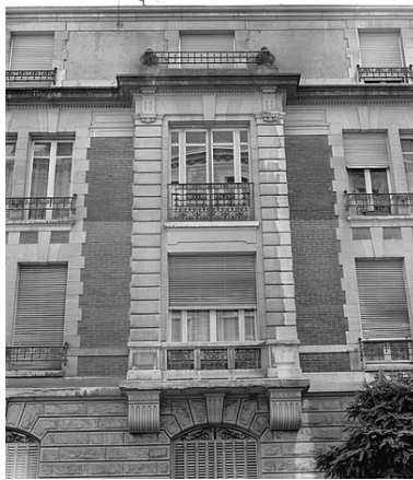
Façade antérieure, détail de l'élévation. Phot. Yves Sancey IVR43_19833900297X
