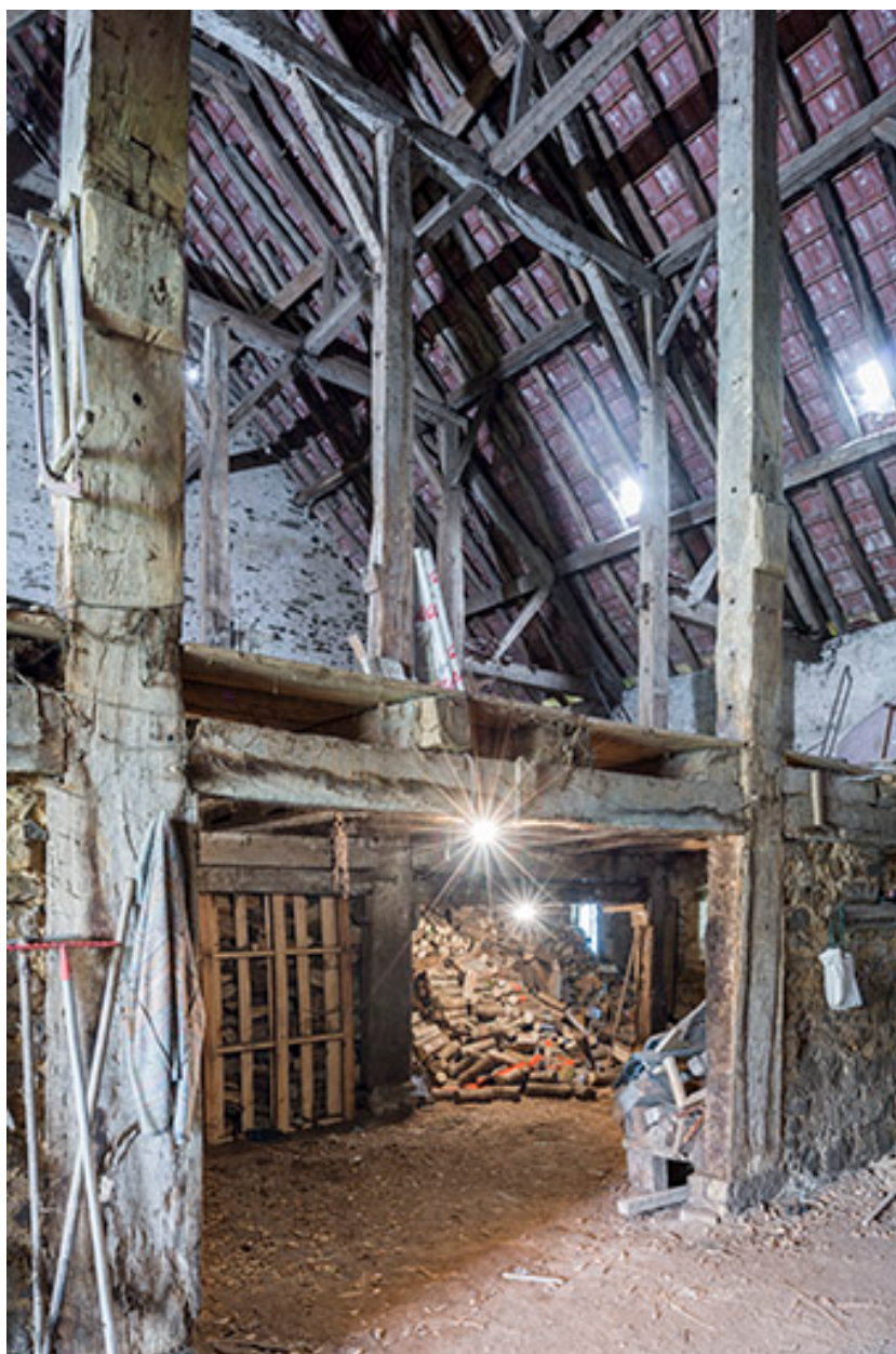
Détail des fermes de la charpente de la grange
