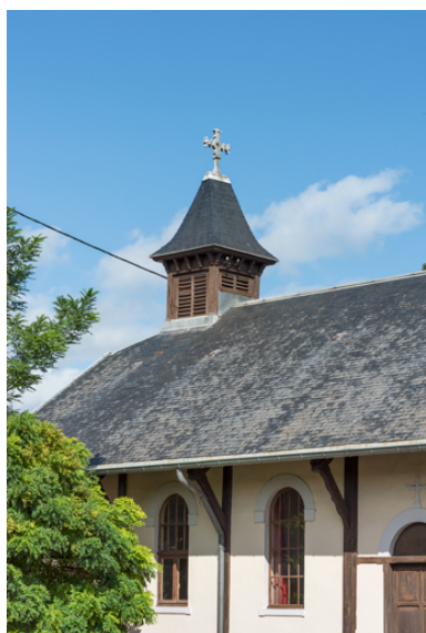
Campanile. Vue de trois quarts depuis le sud ouest. Phot. Pierre-Marie Barbe-Richaud IVR26_20238901095NUC4A
