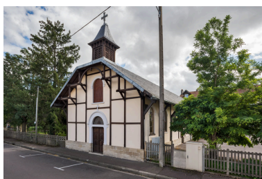
Façade antérieure. Vue de trois quarts. Phot. Pierre-Marie Barbe-Richaud IVR26_20238901088NUC4A
