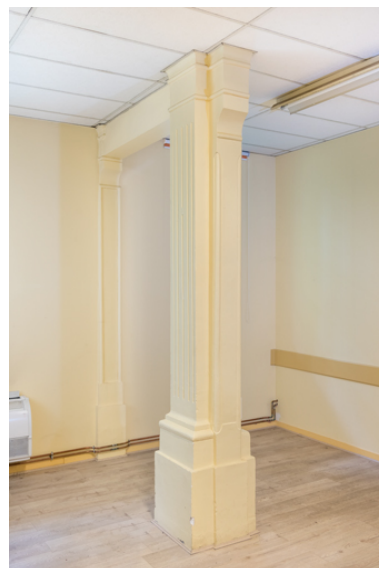
Pilier délimitant l'espace du chœur. Détail. Phot. Pierre-Marie Barbe-Richaud IVR26_20238901102NUC4A
