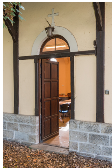
Entrée de la façade est. Vue de trois quarts. Phot. Pierre-Marie Barbe-Richaud IVR26_20238901104NUC4A
