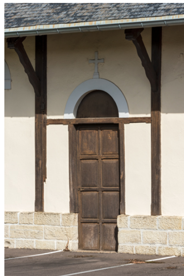
Porte de la façade ouest. Vue de trois quarts. Phot. Pierre-Marie Barbe-Richaud IVR26_20238901097NUC4A
