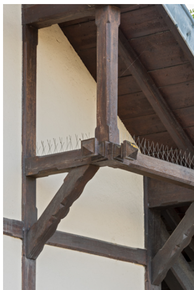
Détail de la charpente en bois. Phot. Pierre-Marie Barbe-Richaud IVR26_20238901091NUC4A
