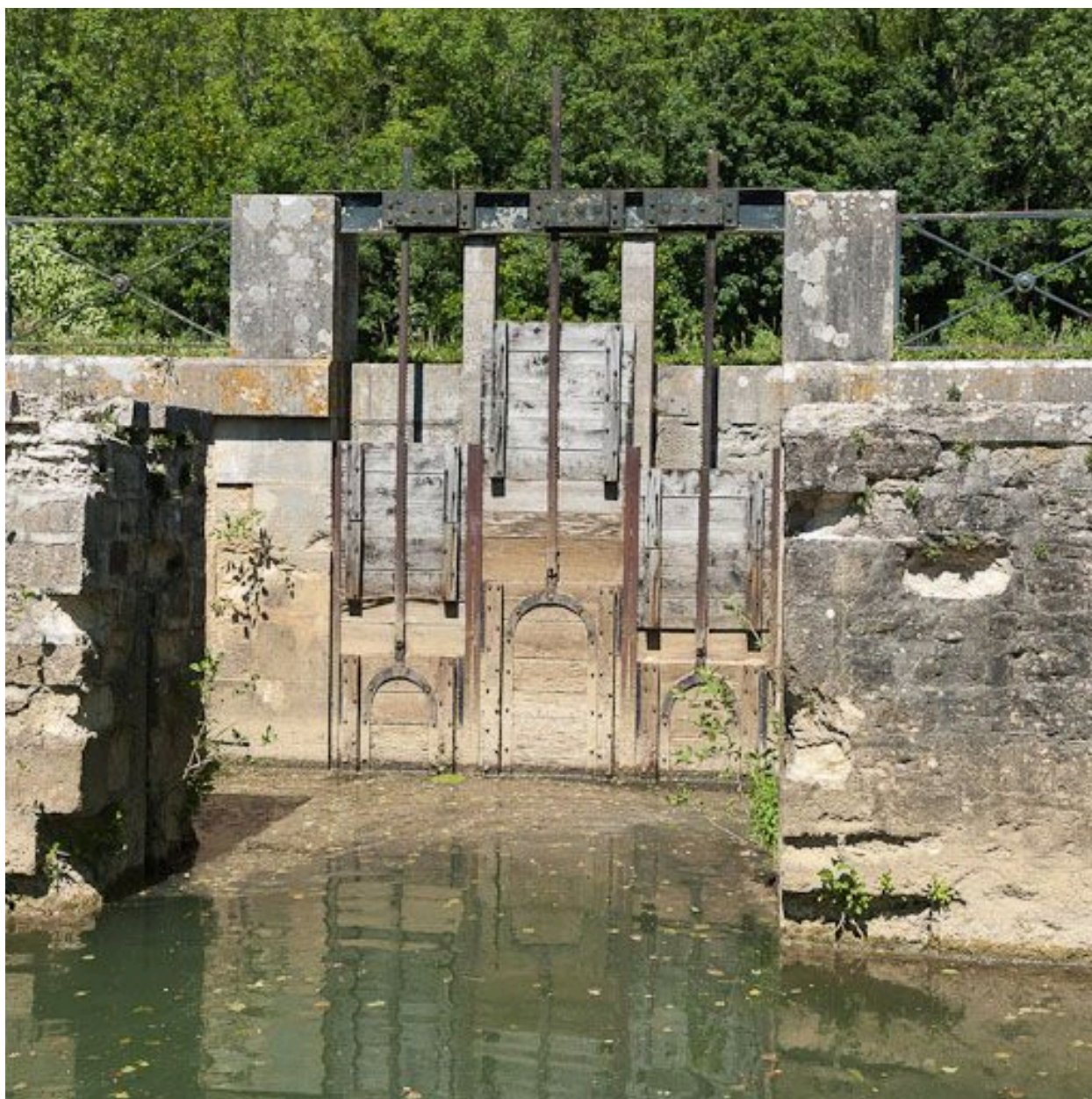
Détail des vannes en bois.
